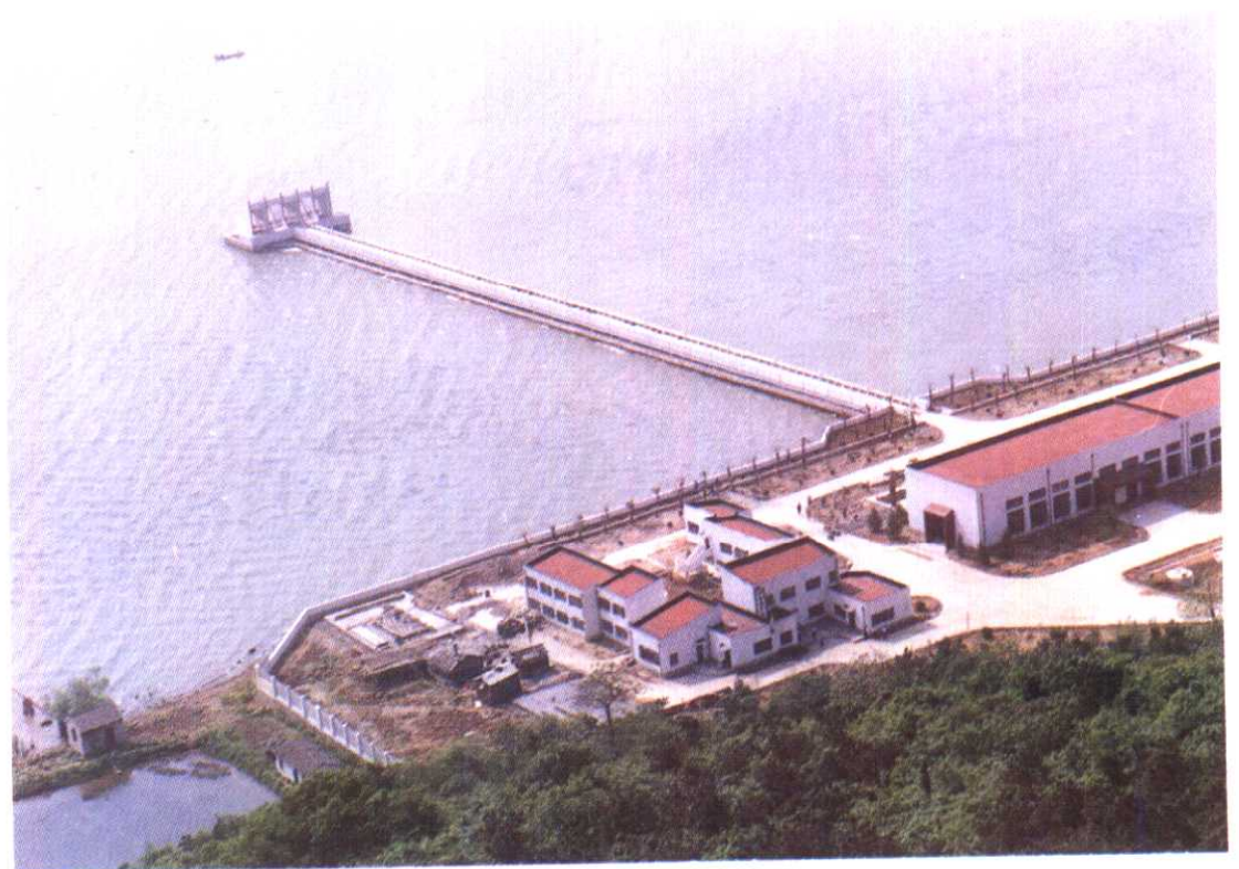
自来水厂取水口
