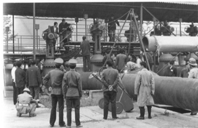
△ 江苏输油管理处仪征站新老管线碰头
