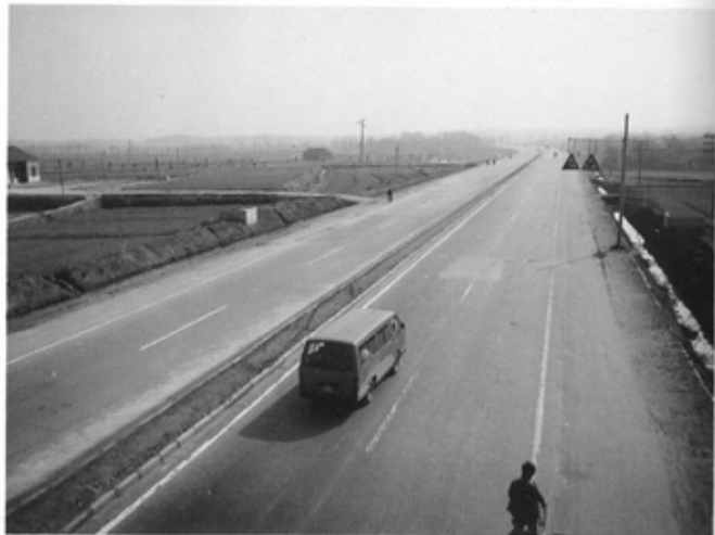
▽ 328 国道南京—扬州一级公路
