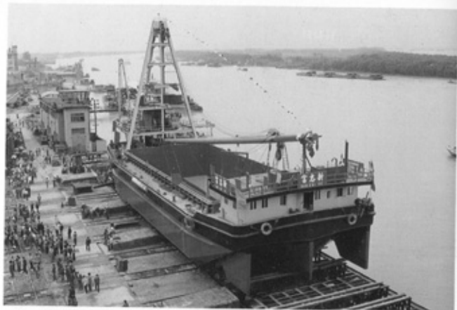
△ 新华船舶修造厂为港商生产的 1600 吨港驳
