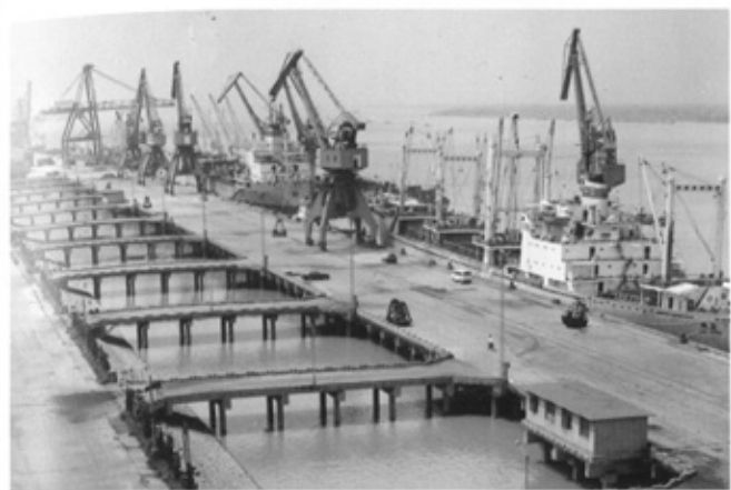
△ 新生圩外贸港区
