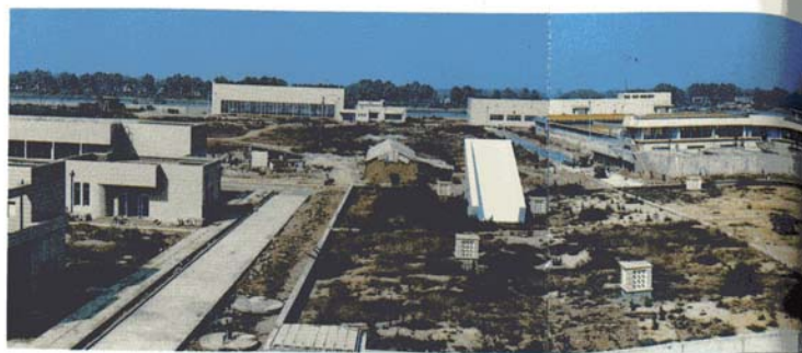
△施工中的北河口水厂 60 万吨/日扩建工程
