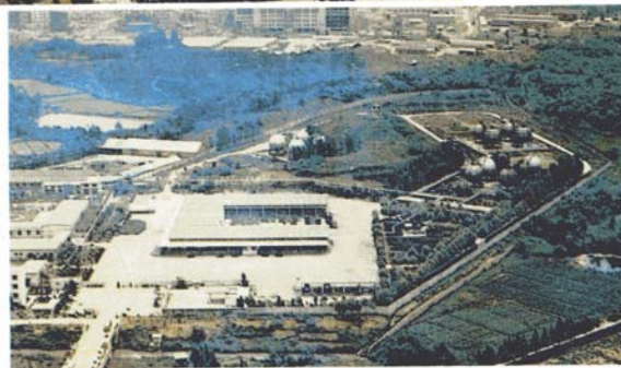
▽液化气第二储灌场
