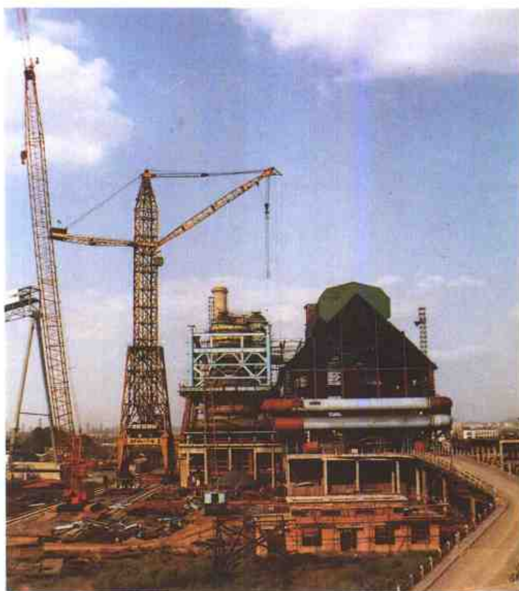
马钢2500立方米大高炉建设工地
