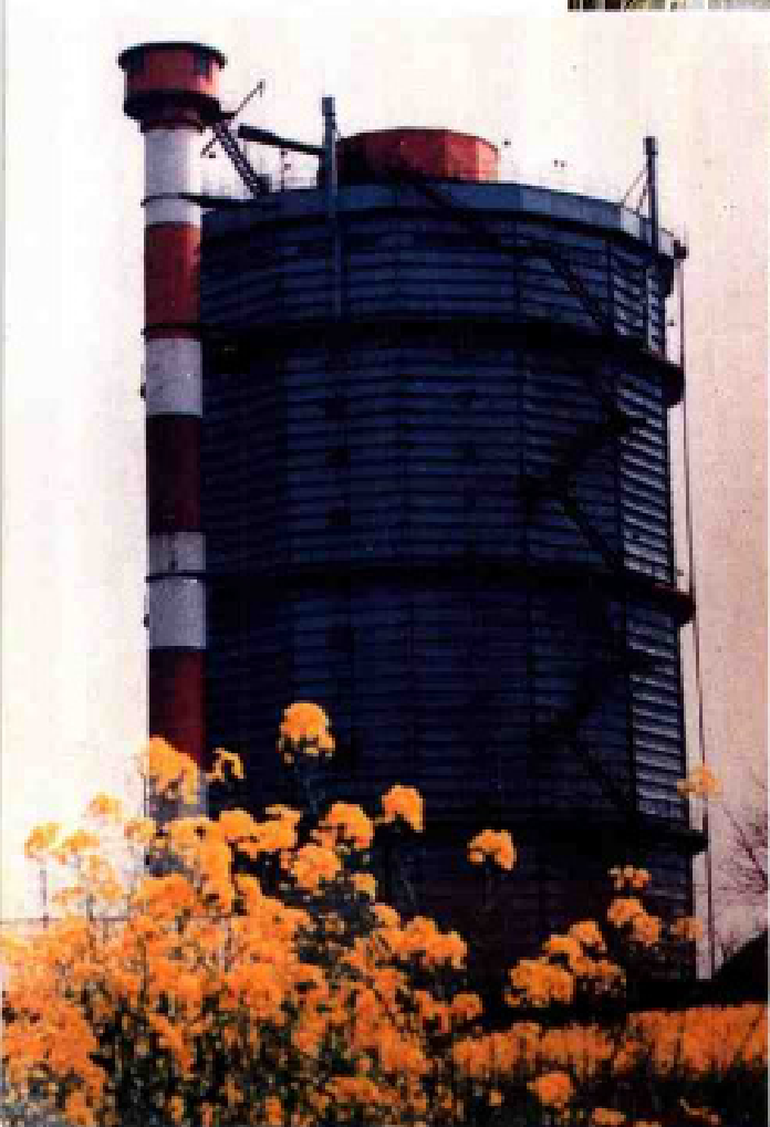
苏州钢铁厂煤气柜。
