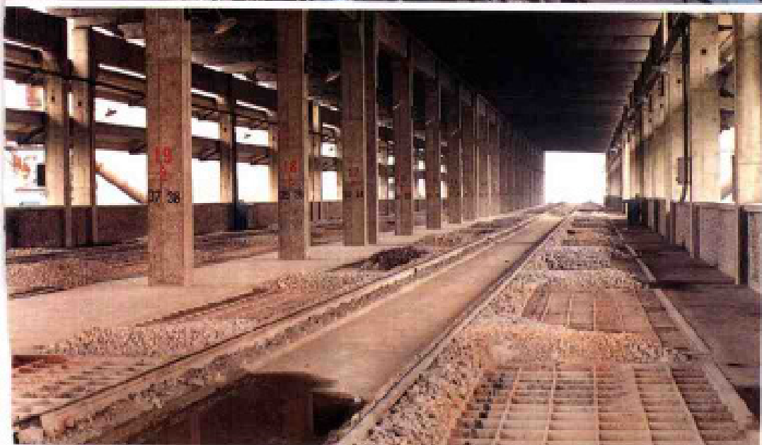
镇江船山石灰石矿运输中转仓，可贮矿石29000吨。
