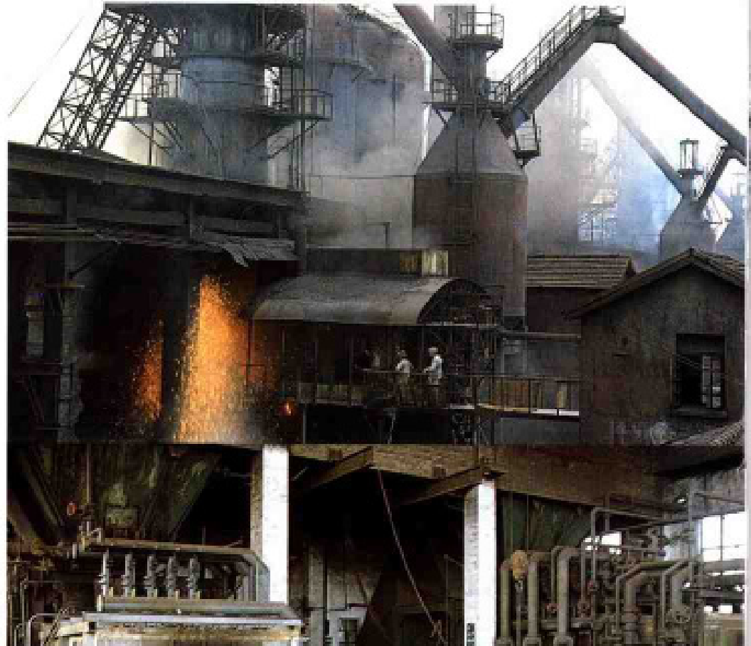
苏州钢铁厂 94 立方米高炉。
