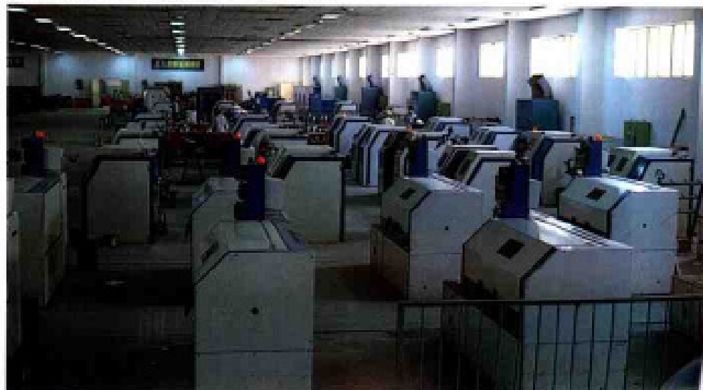
江阴钢绳厂轮胎用钢丝帘线生产车间。
