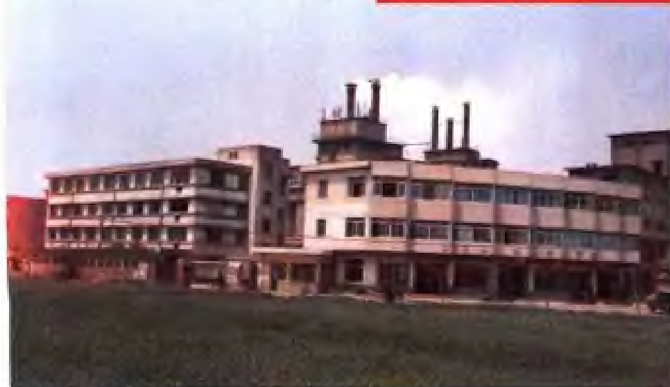
江阴水泥厂厂区
