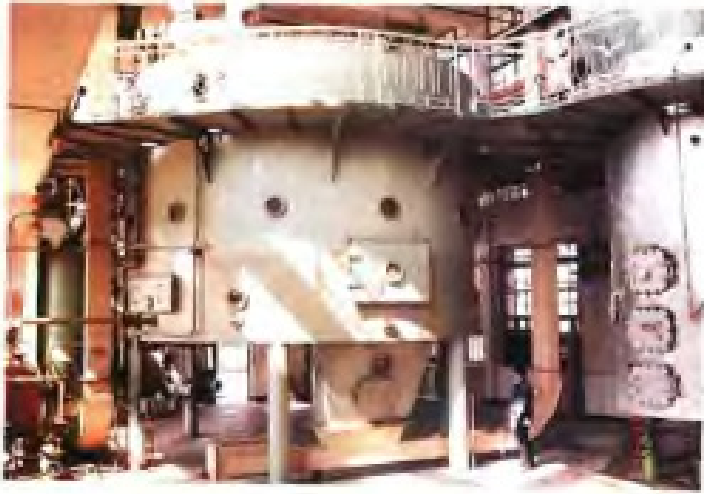
42、昆山市油脂化工厂浸出车间
