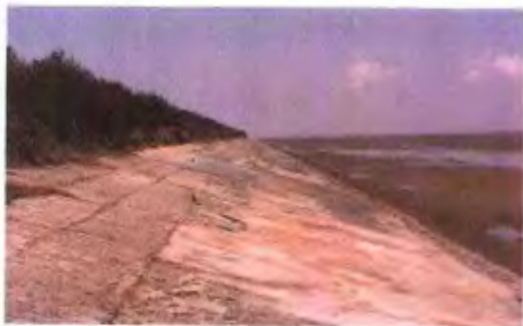
▲ 混凝土护坡
