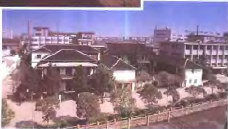
张謇在公司内的 办公楼
