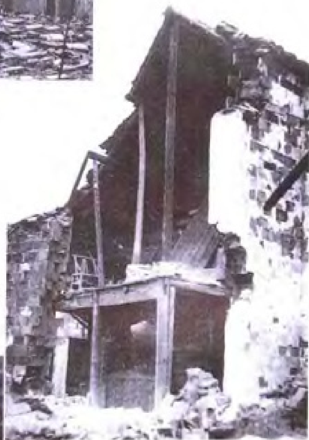
溧阳上沛民居两层楼房墙体垮落，木柱歪斜。
