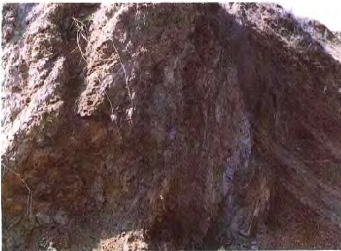
宿迁晓店东郯城——庐江断裂带中的第四纪断层（下白垩统青山组安山岩(K 1 )逆冲于第四系黄土(Q 3 )之上）。
