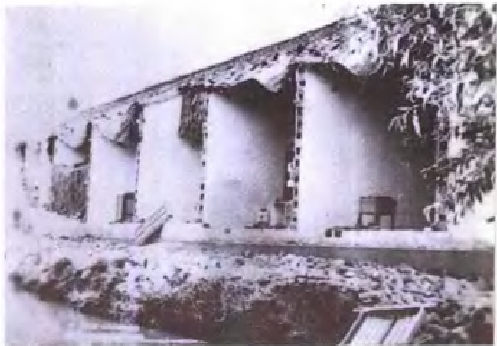
溧阳汤桥下步岗平房檐墙倒塌。
