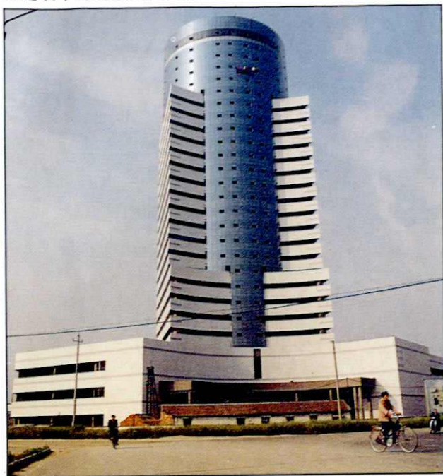
●建设中的海安建工大厦
