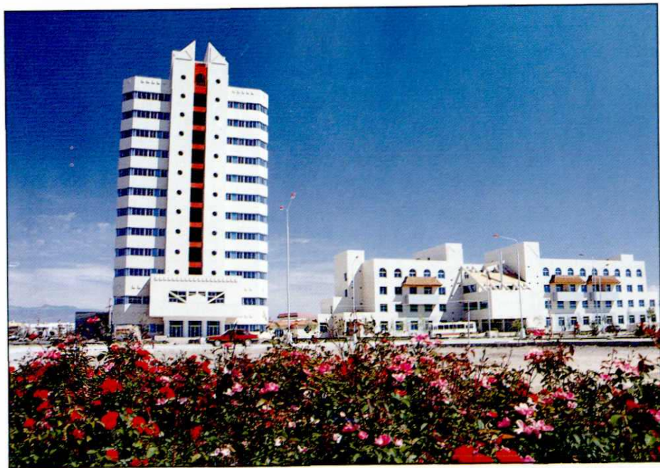
●南通市第七建筑安装工程公司承建的新疆吐哈油田内外宾接待公寓
