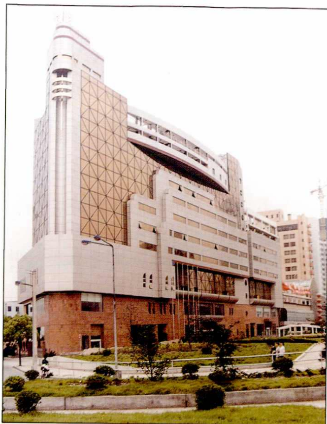
●南通市七建第九分公司在上海承建的大庆石油大厦辅楼
