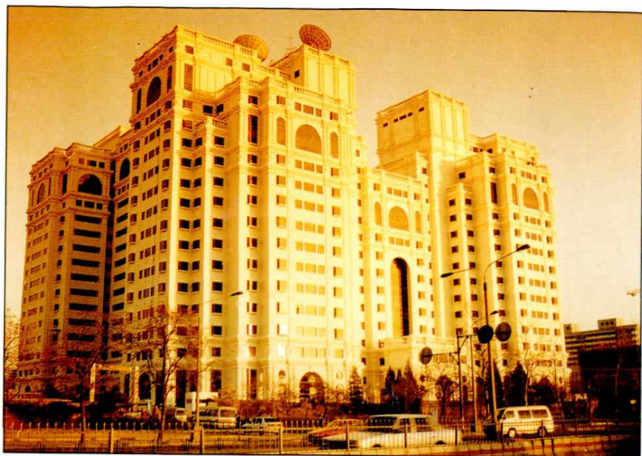
●南通苏中建筑安装工程公司承建的北京富华大厦
