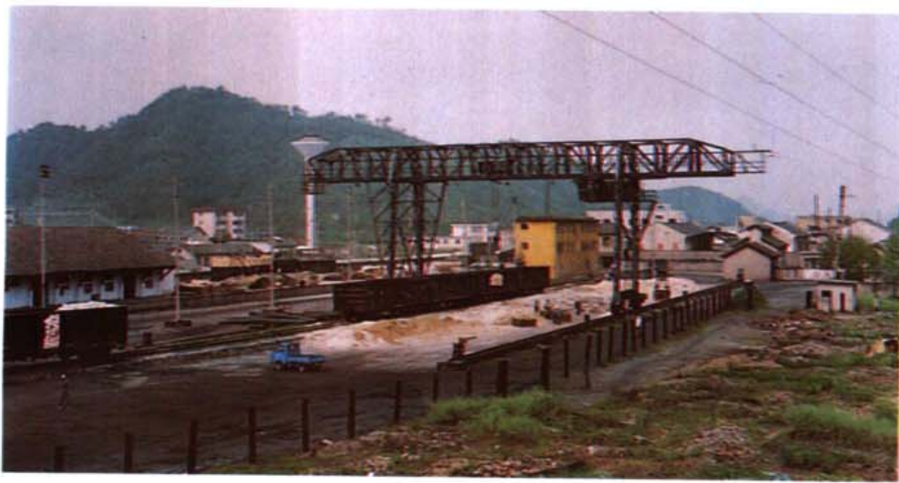
屯溪火车站货场龙门吊
