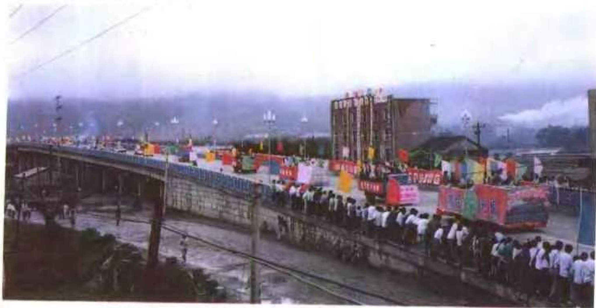
巢湖铸造厂立交桥
