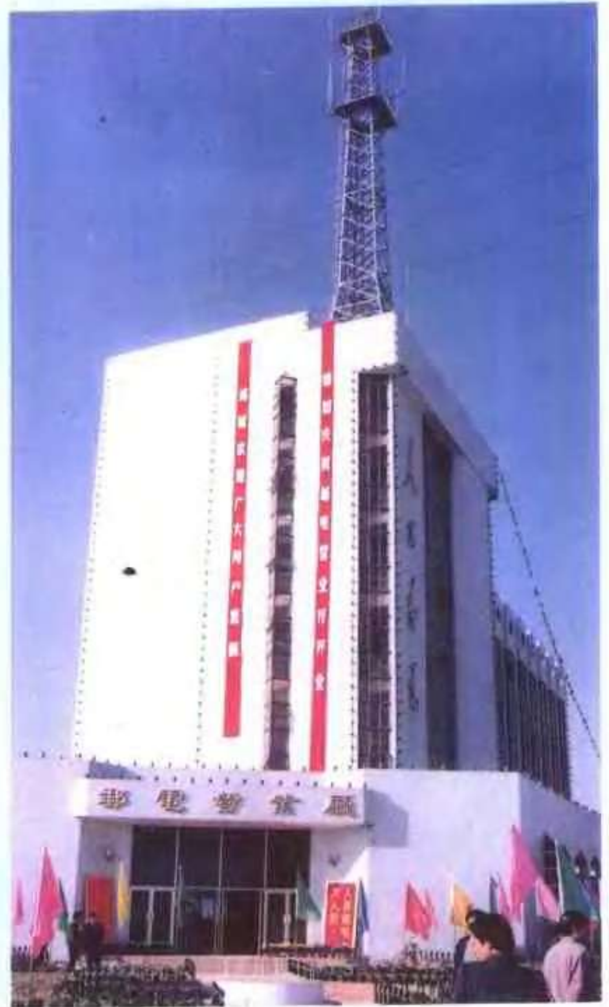
巢湖邮电大楼
