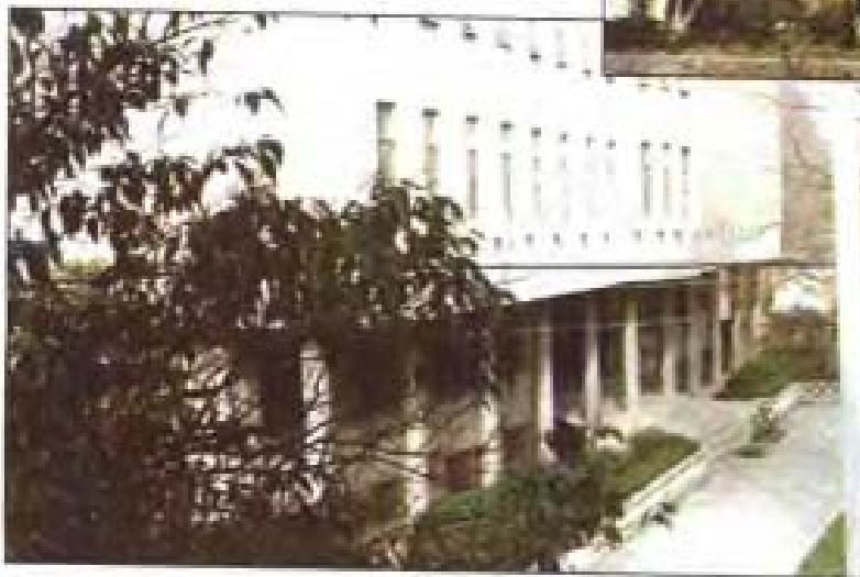
滁州市档案馆大楼
