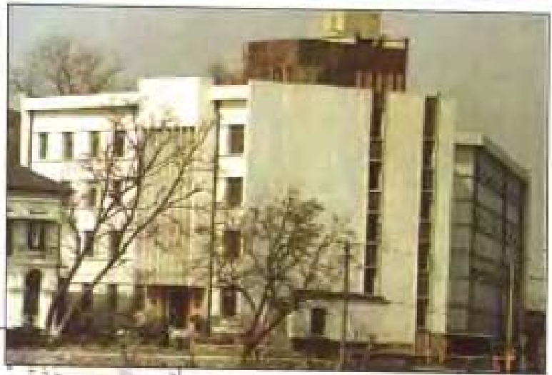
芜湖市档案馆大楼
