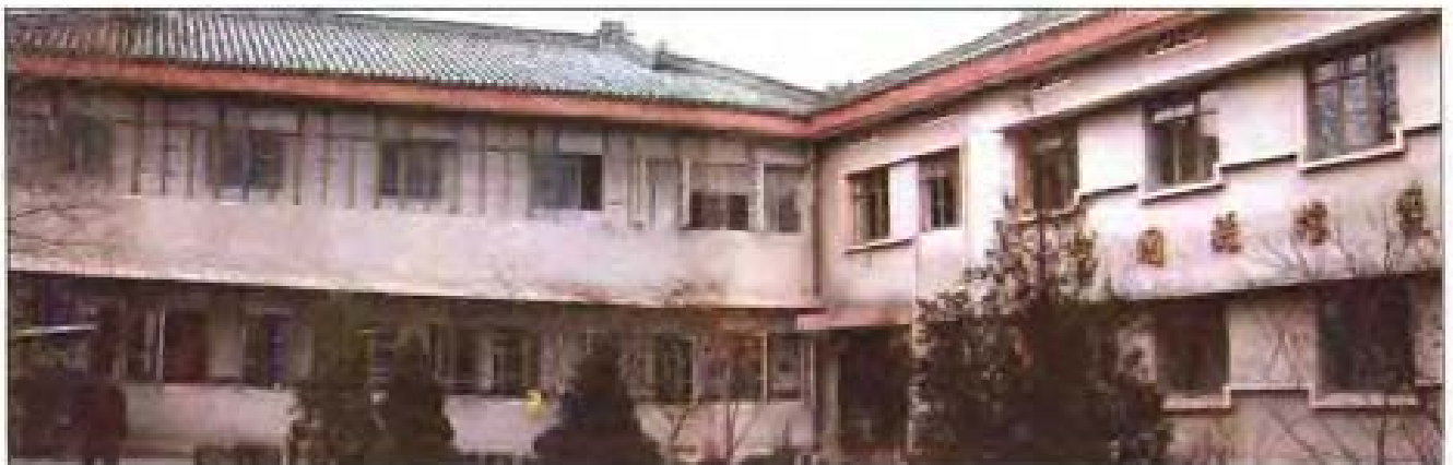
宁国县档案馆楼群
