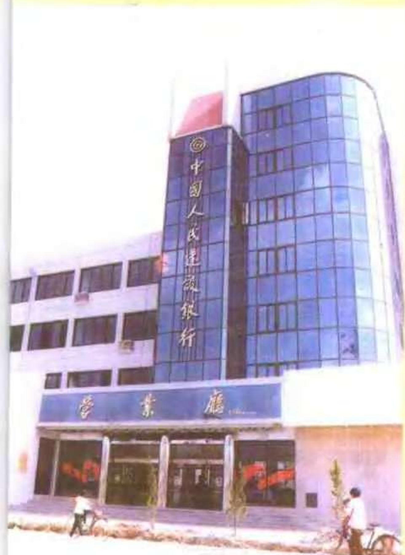
建设银行大楼
