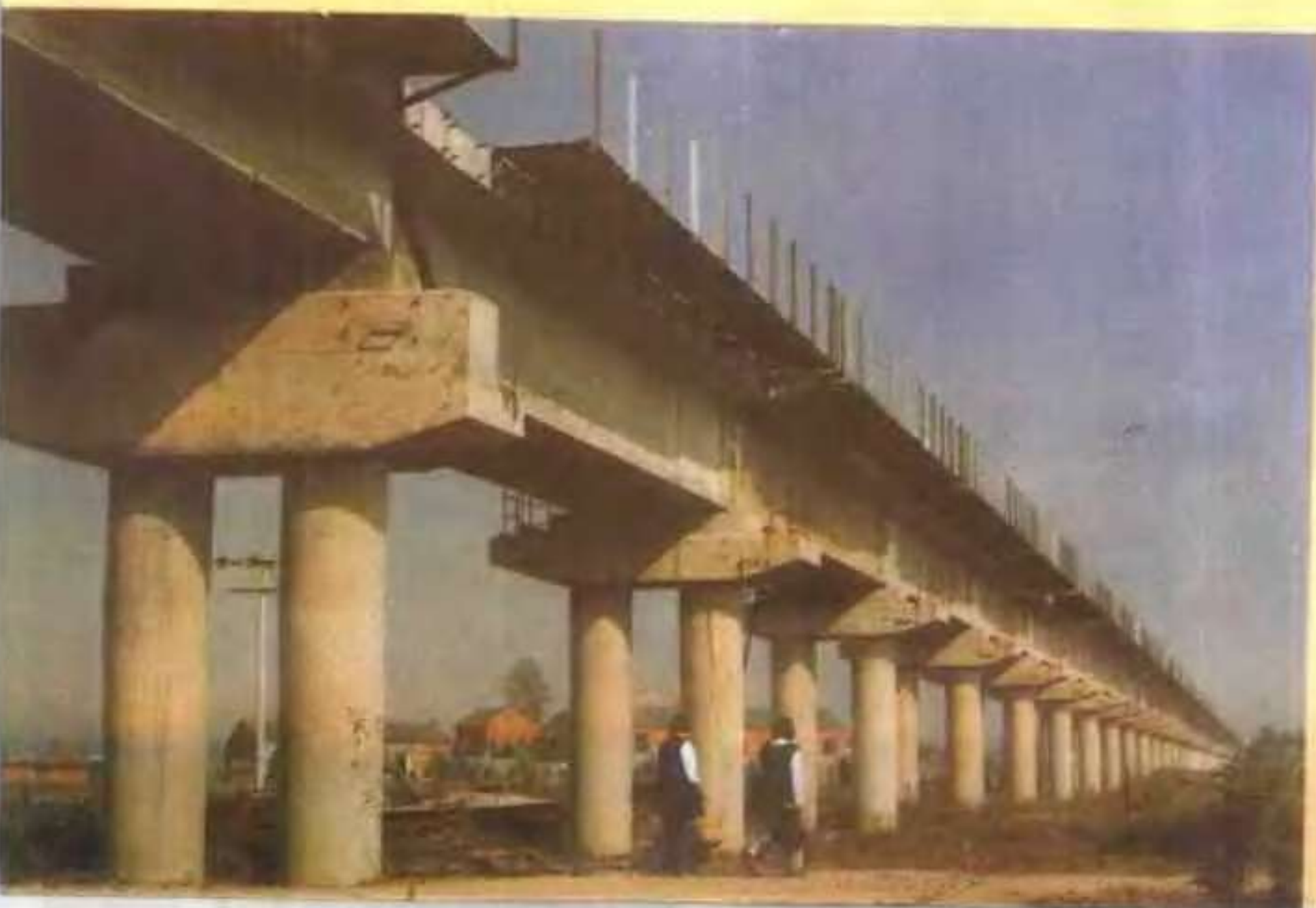
合九铁路舒城段高架桥
