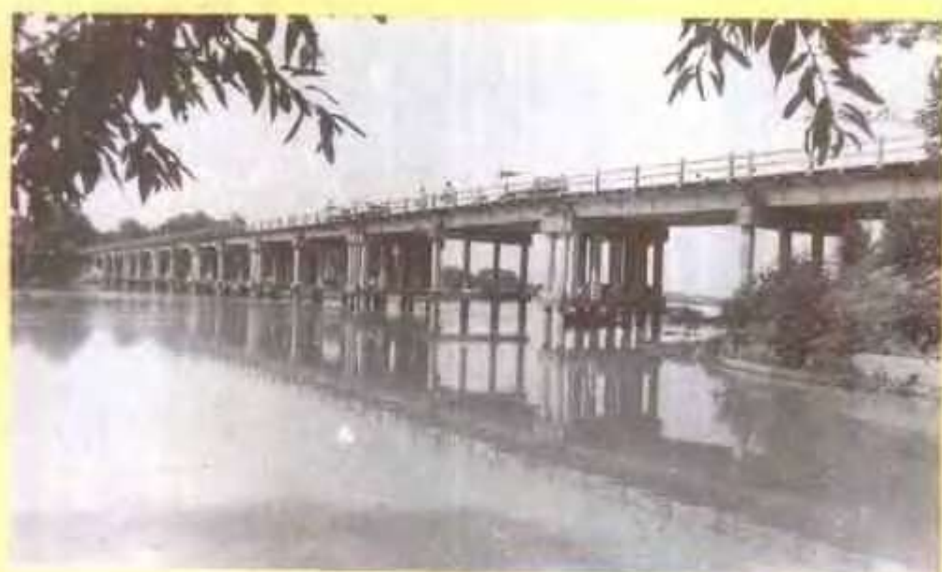
马家河口大桥
