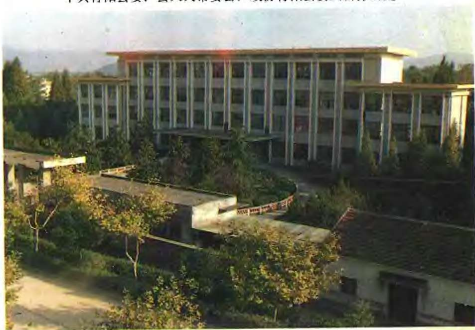
县人民政府办公楼
