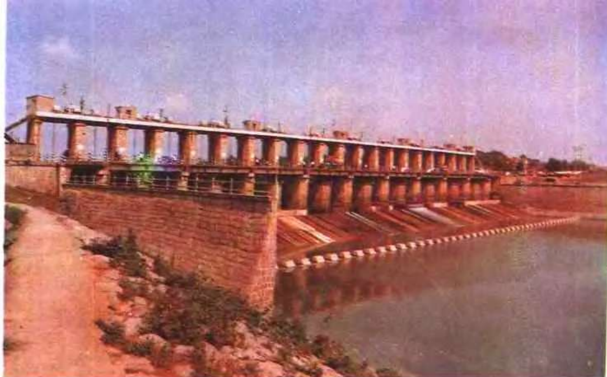
◁ 蒙城县涡河分洪闸
