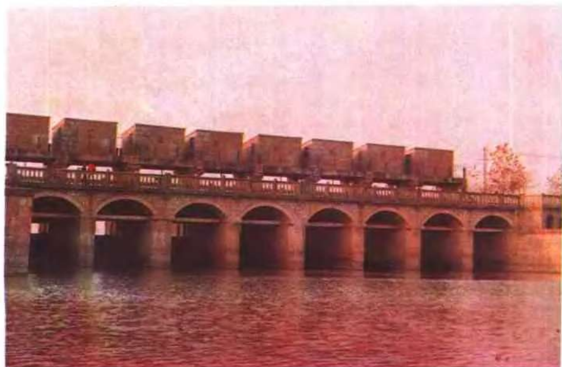
◁ 蒙城县茨河 陈桥闸
