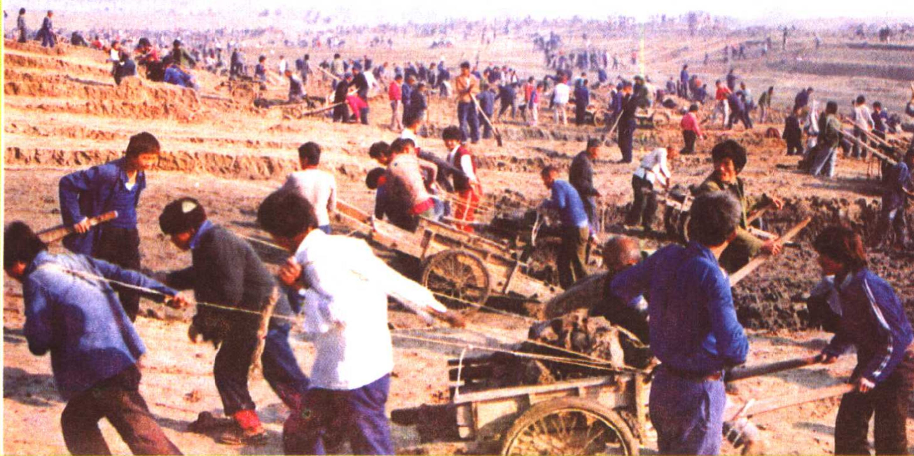
治理流鞍河工地
