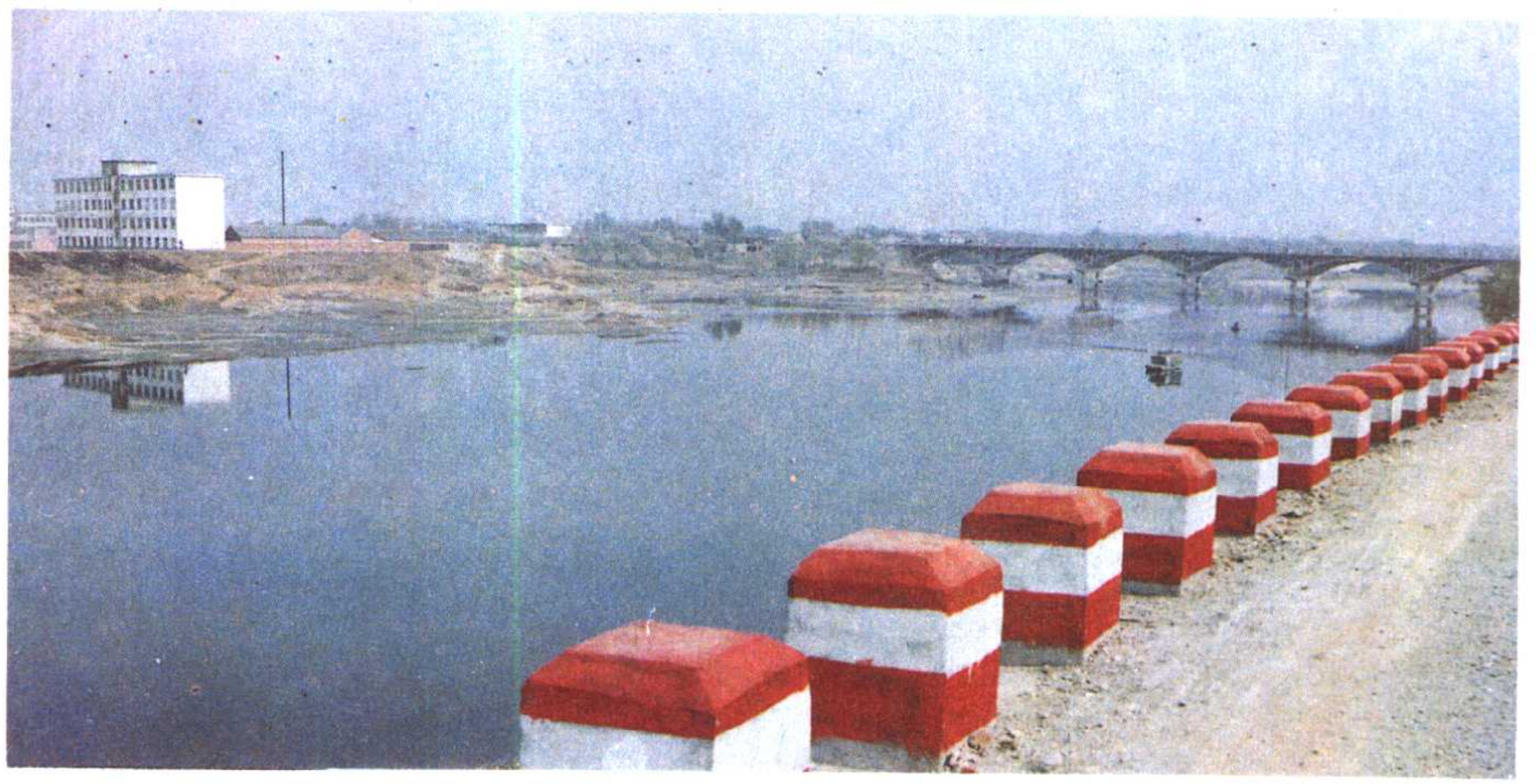
临泉县泉河大桥
