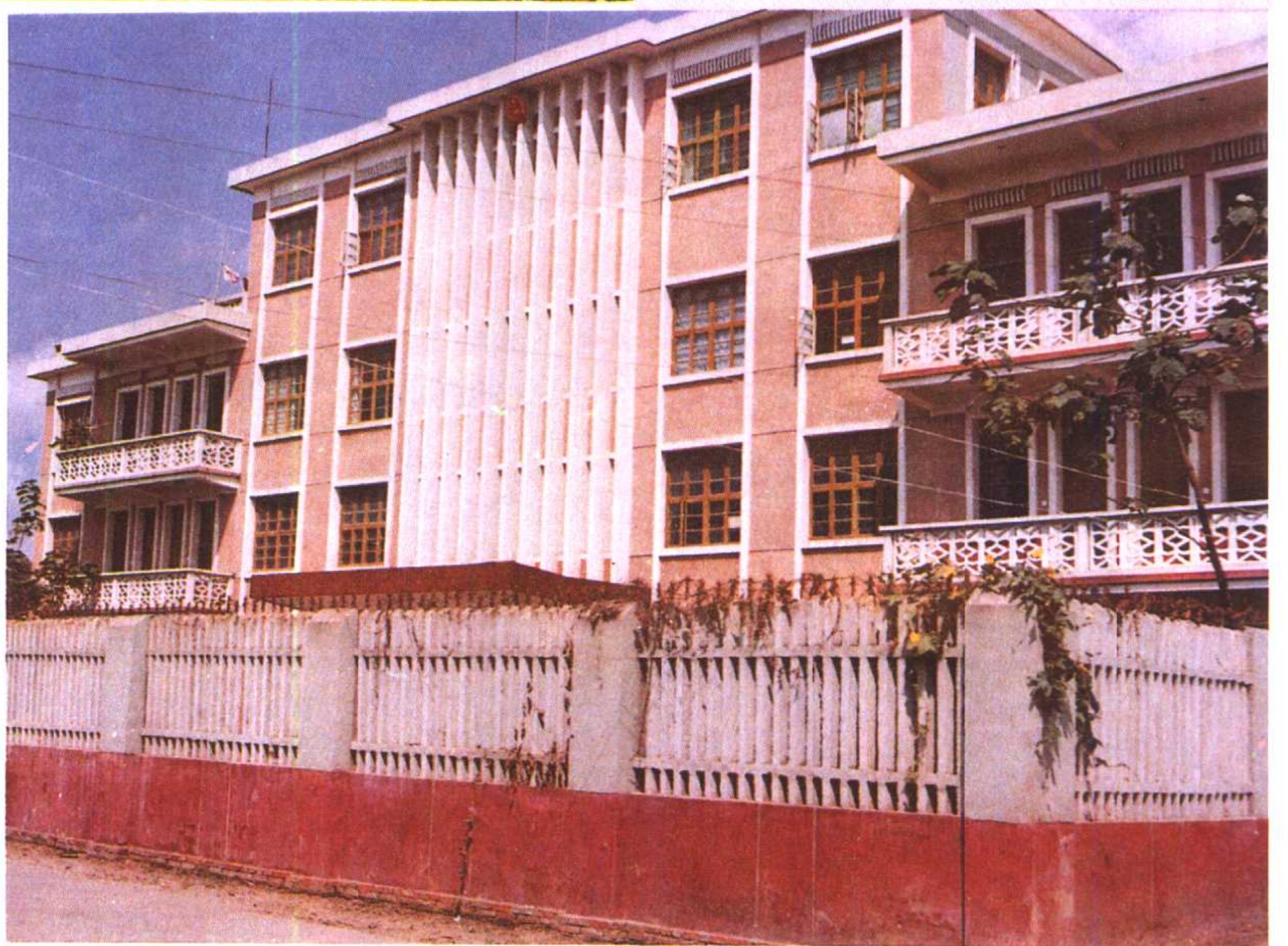
临泉县人民代表大会 常务委员会办公楼
