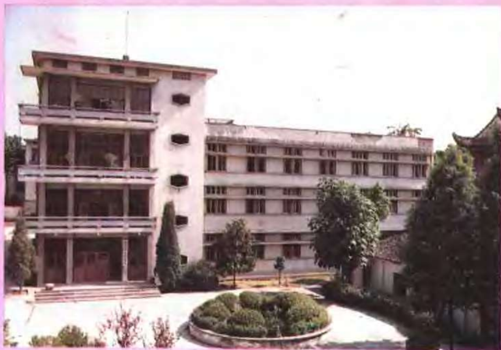
旌德县人民政府办公楼
