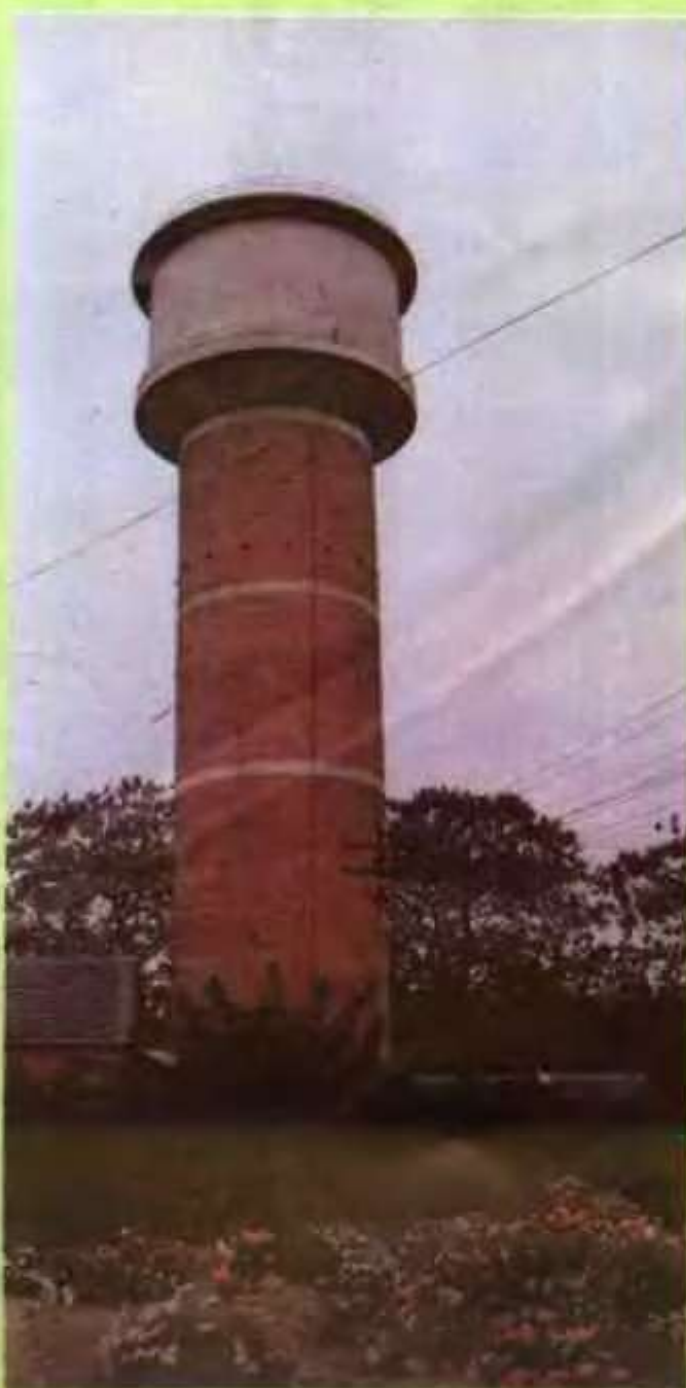
自来水厂水塔
