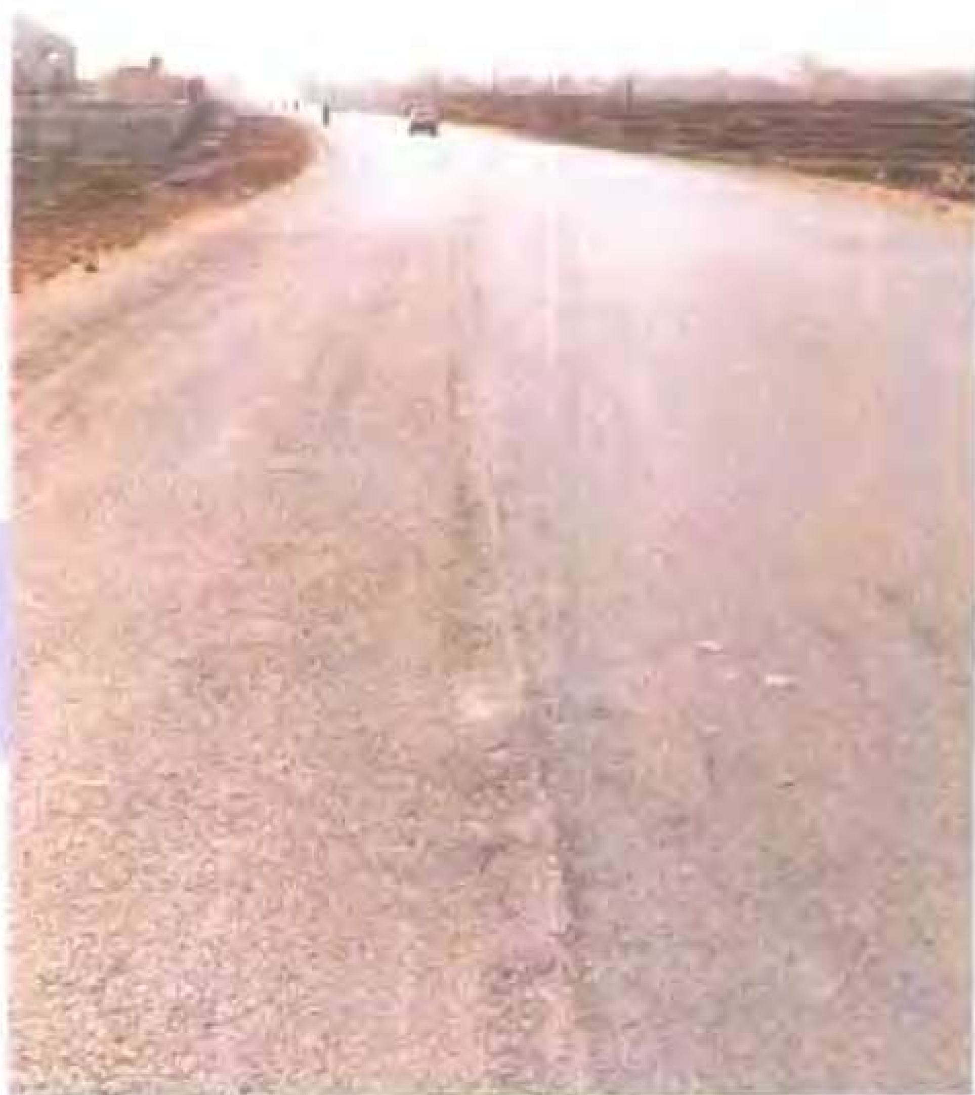
拓宽改造后的柘乌公路
