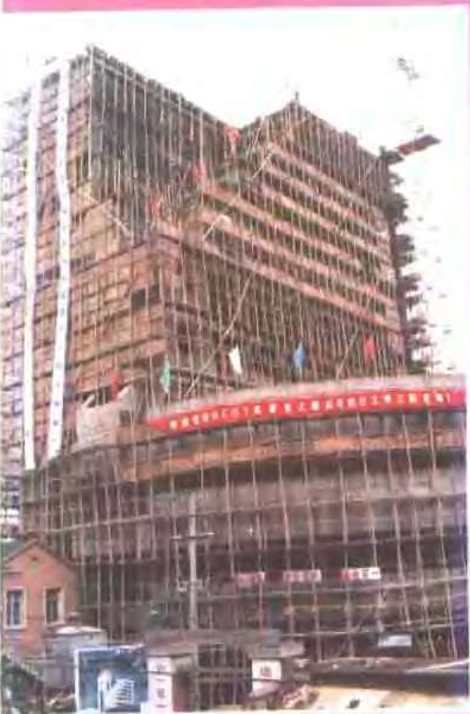
县一建公司承建的县工商行大楼
