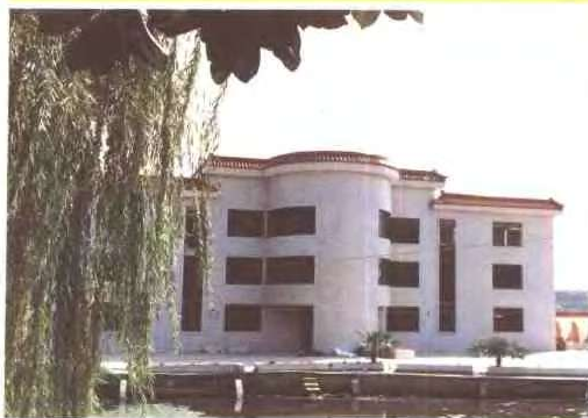
县一建公司承建的昭关宾馆小楼
