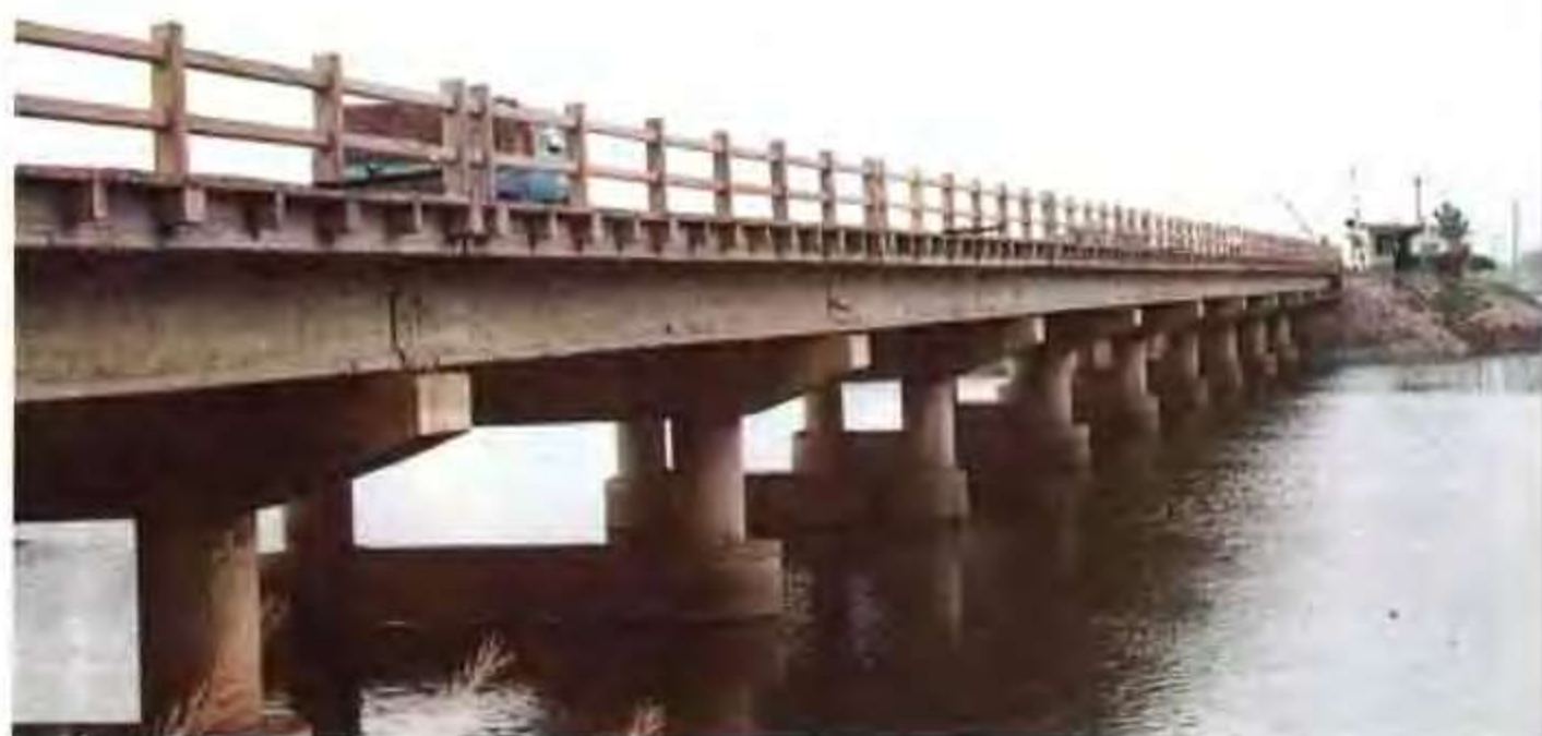
(23) 灞河公路大桥
