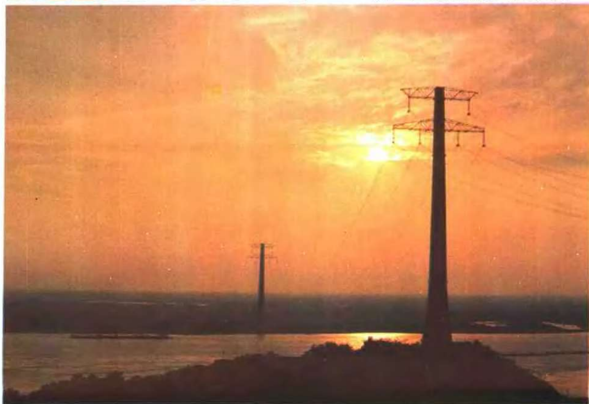
淮南—上海50万伏输变电线过江电塔
