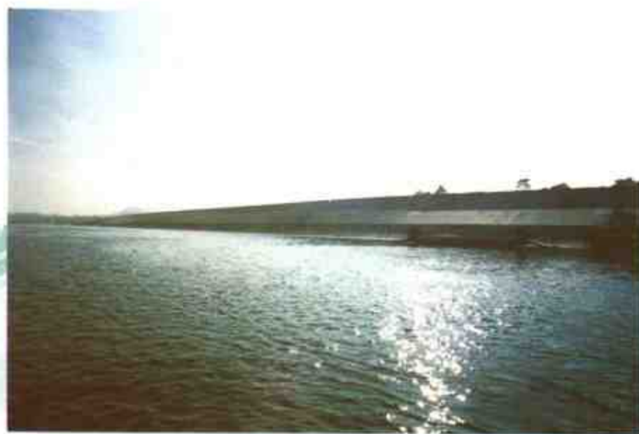
加固和新修的百里河堤
