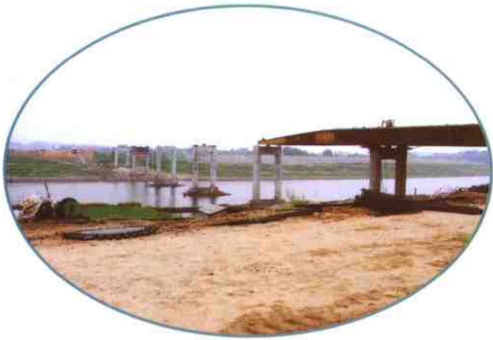
建设中的渌水大桥
