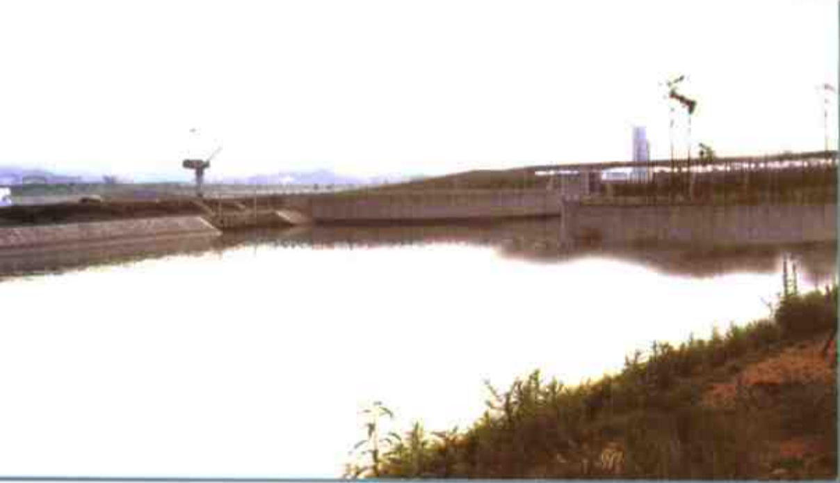
建设中的株洲航电枢纽工程
