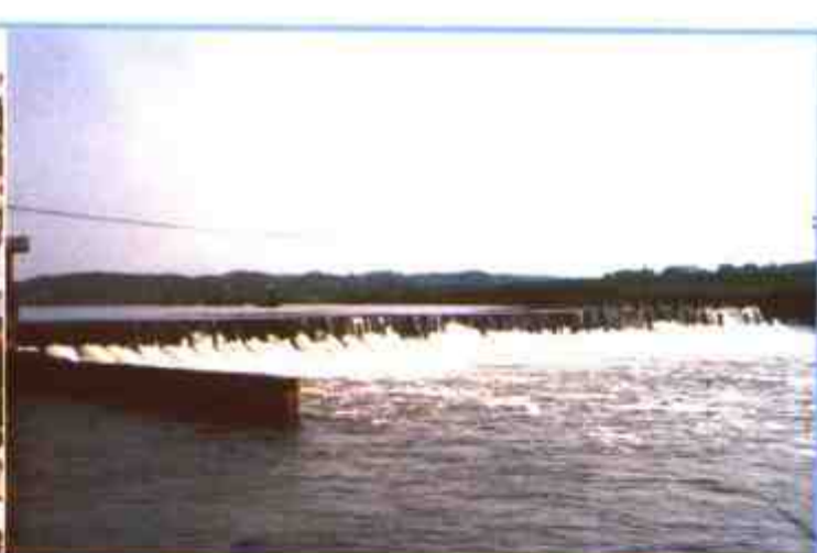
涑口水电站拦河大坝
