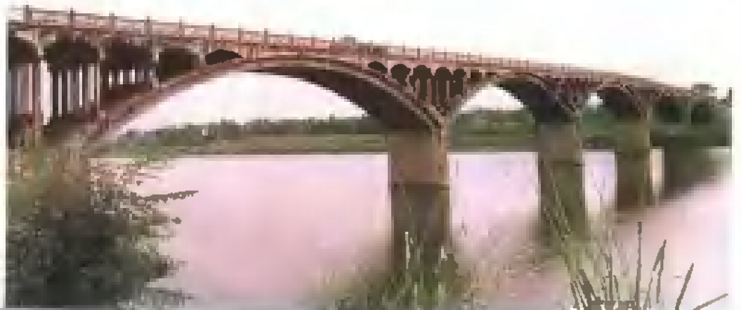
▷ 溇口公路大桥
