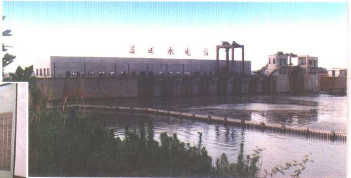
△ 遙田水電站裝機容量 4 \times 1.25 萬千瓦，年發電量 2.56 億千瓦小時。
