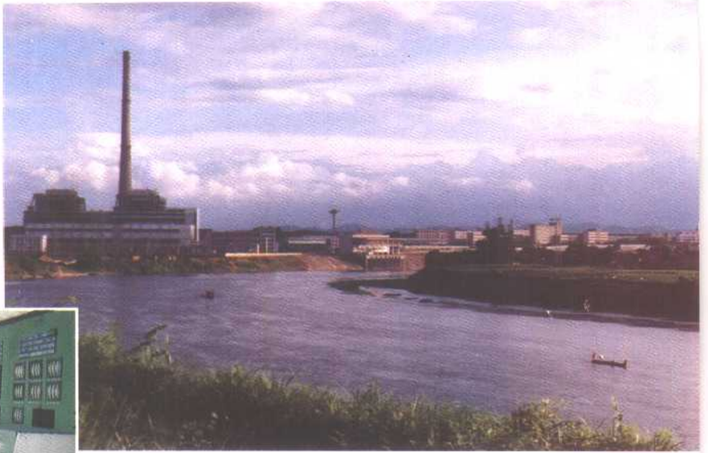
△ 耒陽火電廠裝機容量 2 \times 20 萬千瓦，年發電量 17.535 億千瓦小時。
