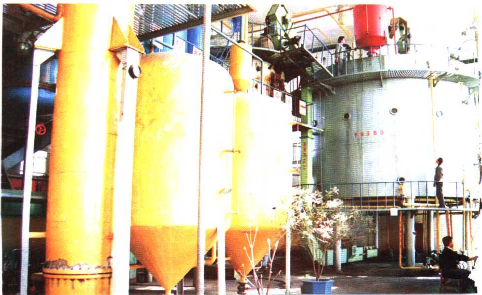
植物油厂浸油车间
