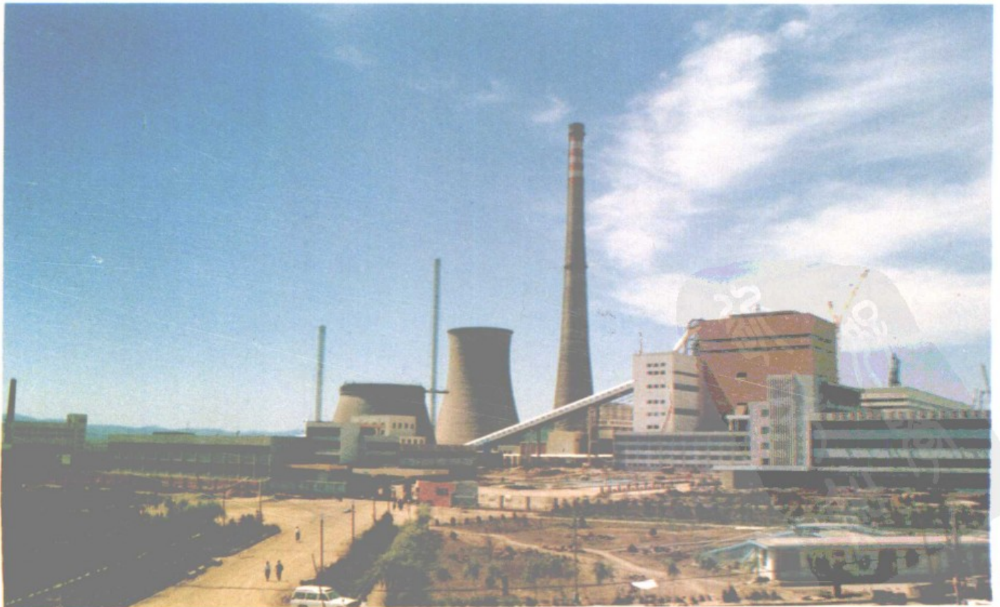
建設中的雙鴨山發電廠
