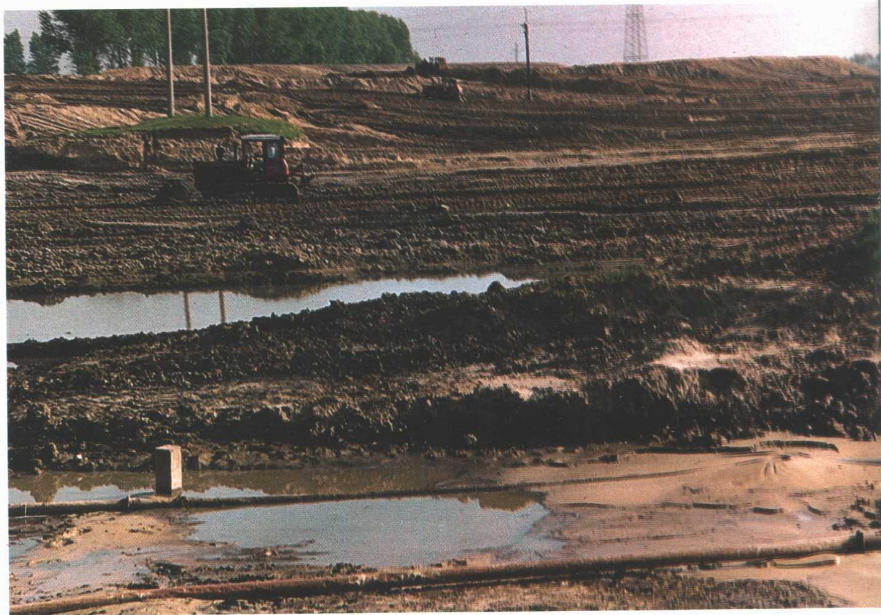
整修蒲河大堤
