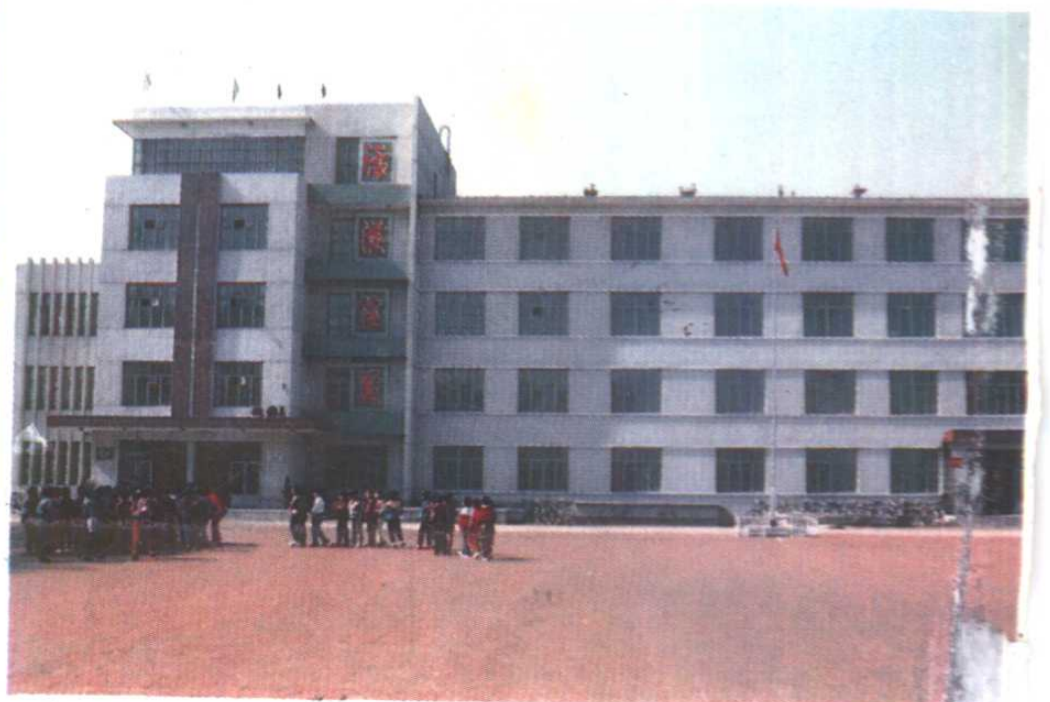
县实验小学楼
