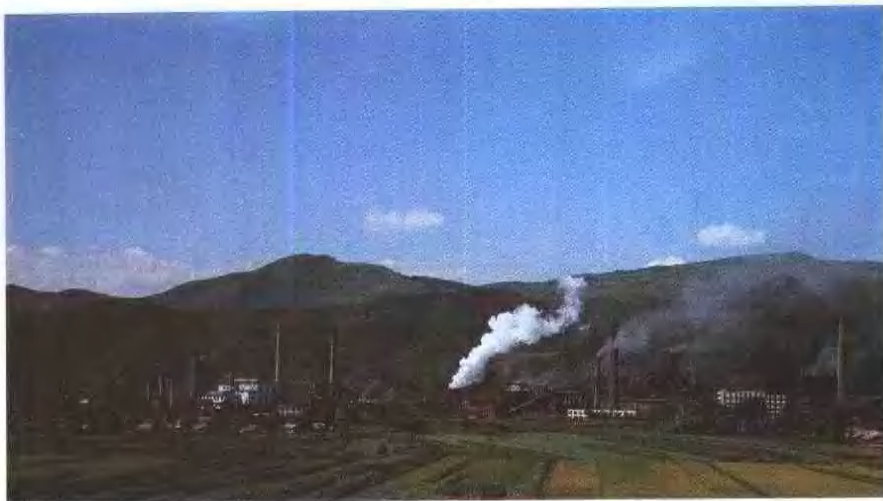
◀ 北台鋼鐵總廠全景
