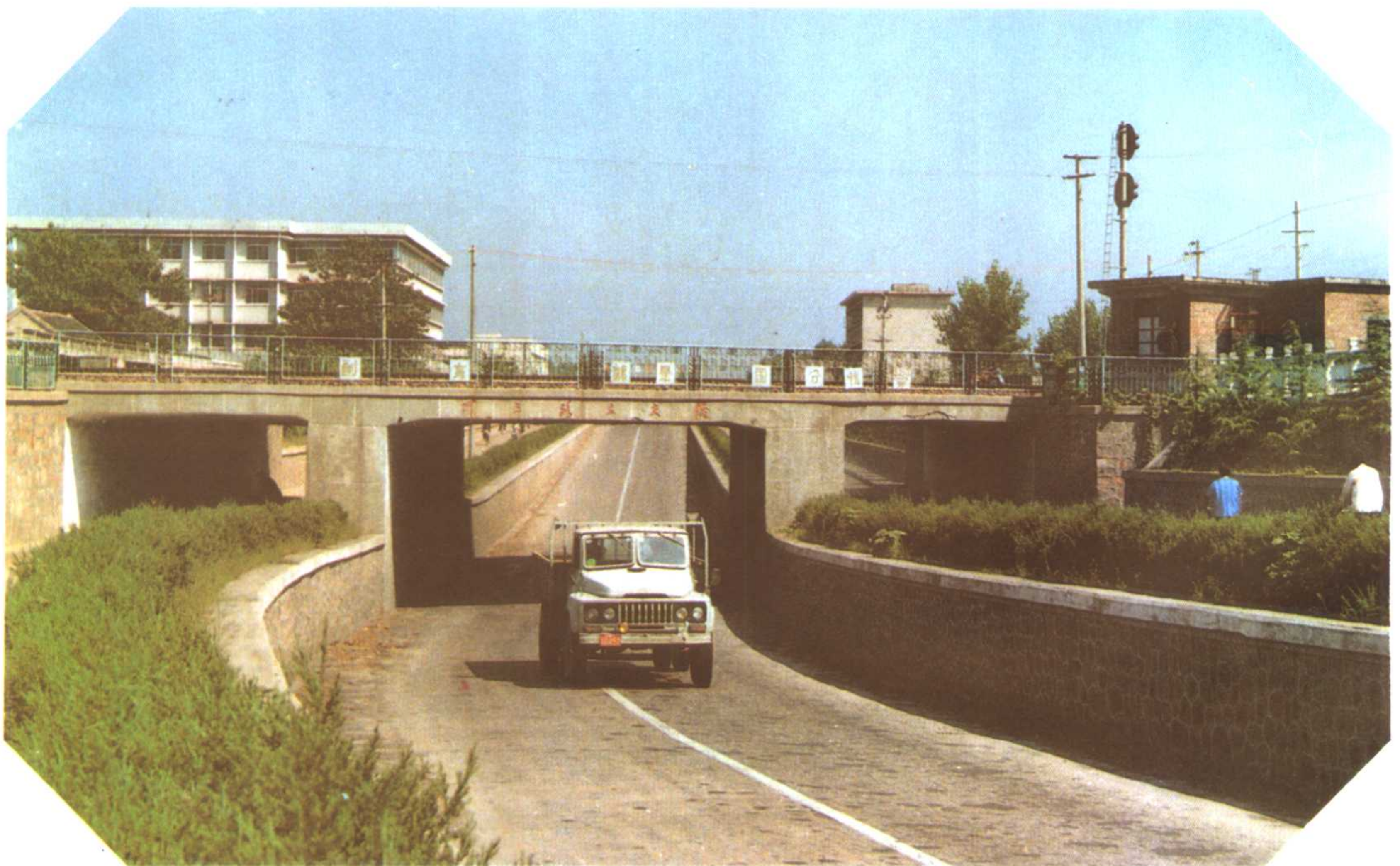
解放路立交桥
