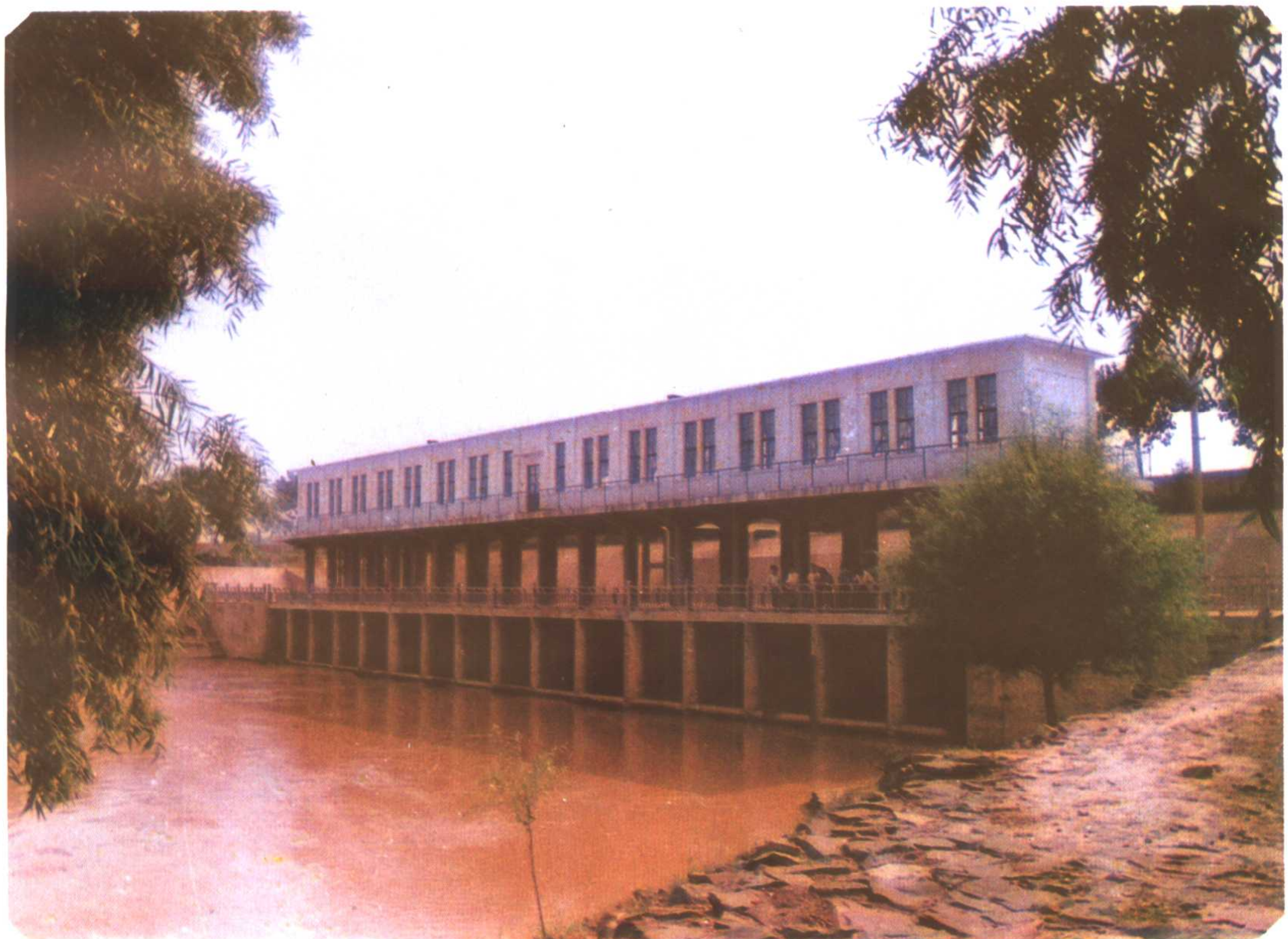
中牟赵口引黄灌溉渠首闸
