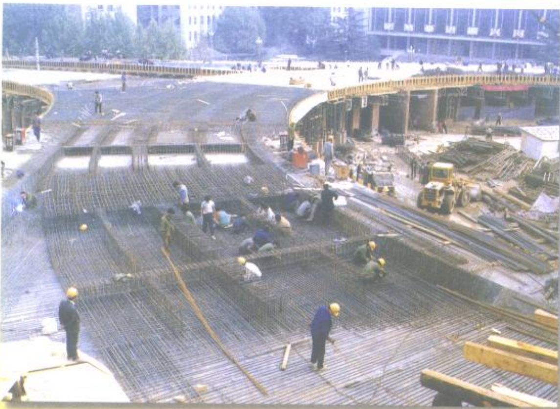
紫荆山立交桥施工现场
