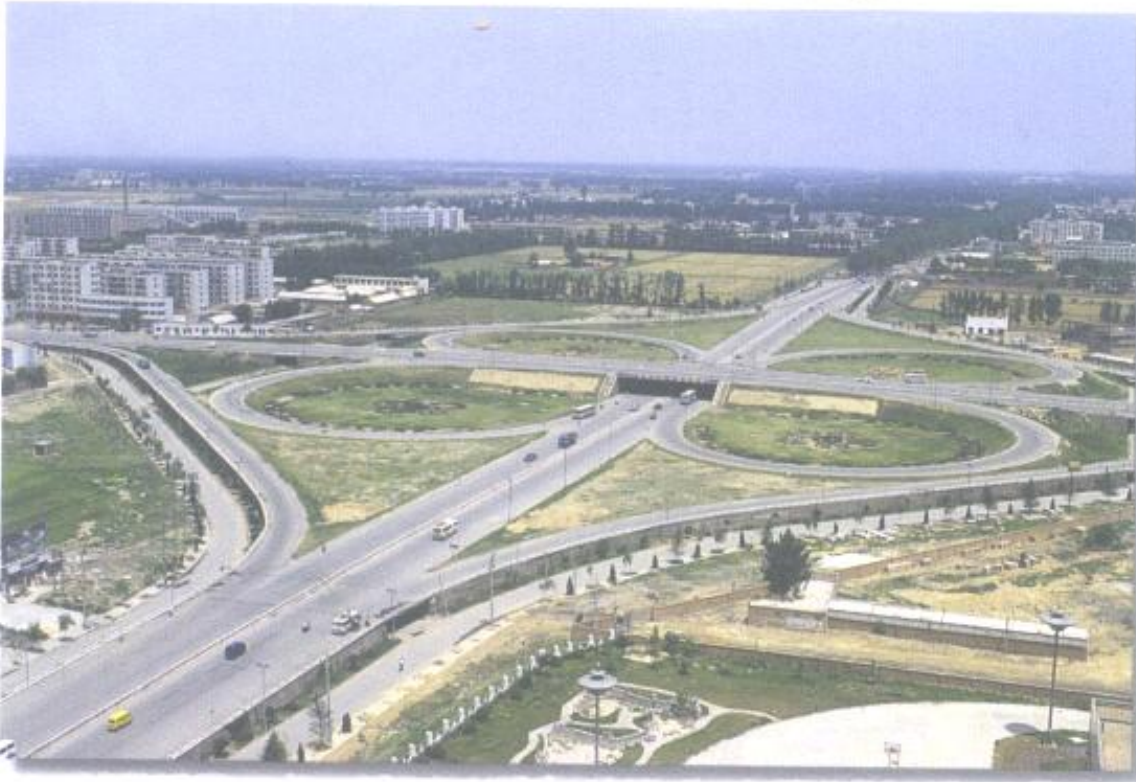
北环路立交桥
