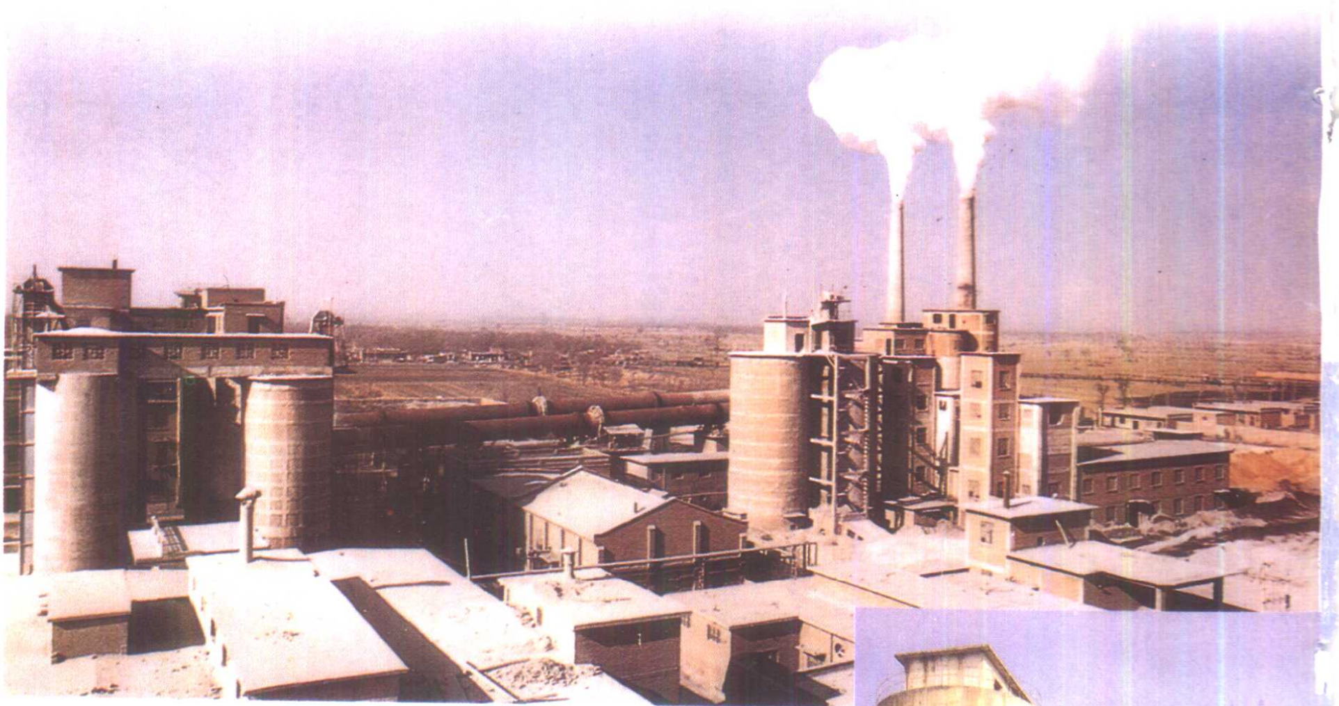
水泥总厂一角
