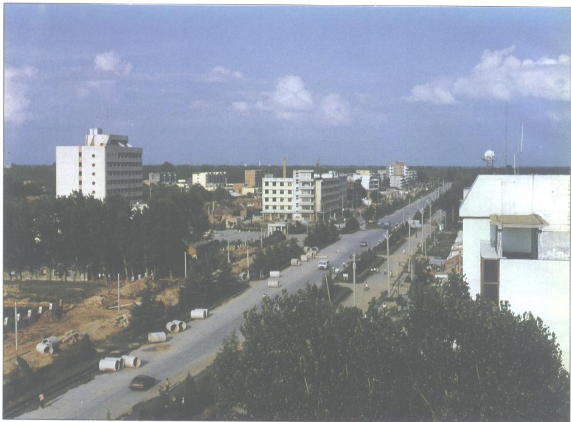
建设中的永城新城
