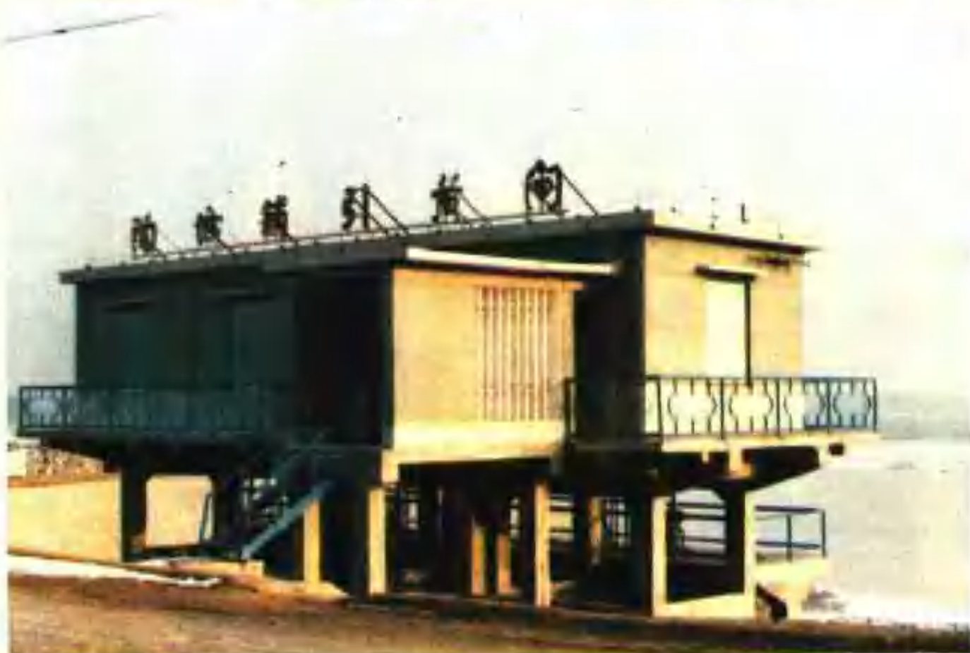
陶城铺引黄灌区渠首闸
