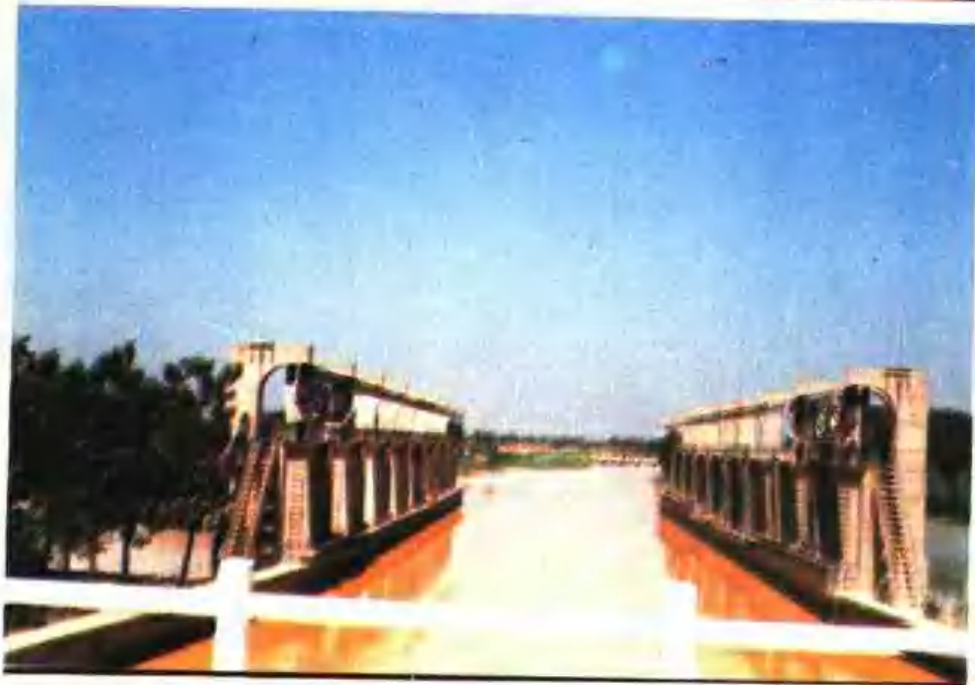
位山引黄灌区三千渠王铺渡槽
