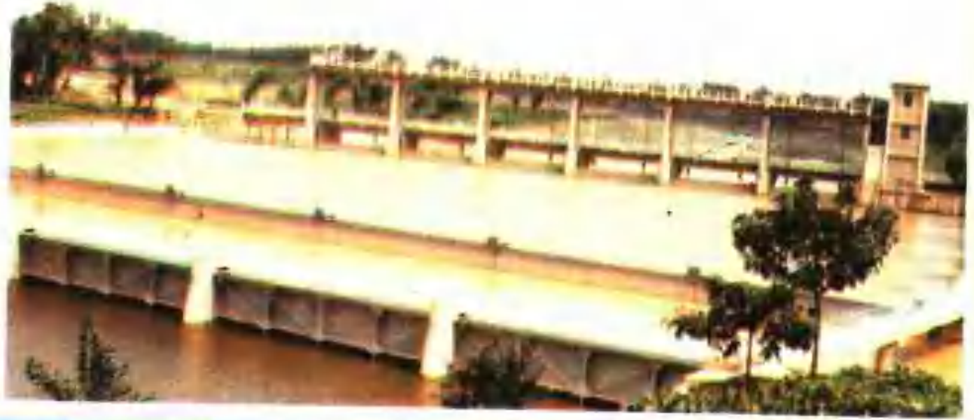
位山引黄灌区三千渠王堤口渡槽
