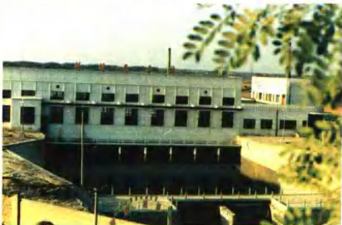
陶城铺引黄灌区骆驼巷泵站
