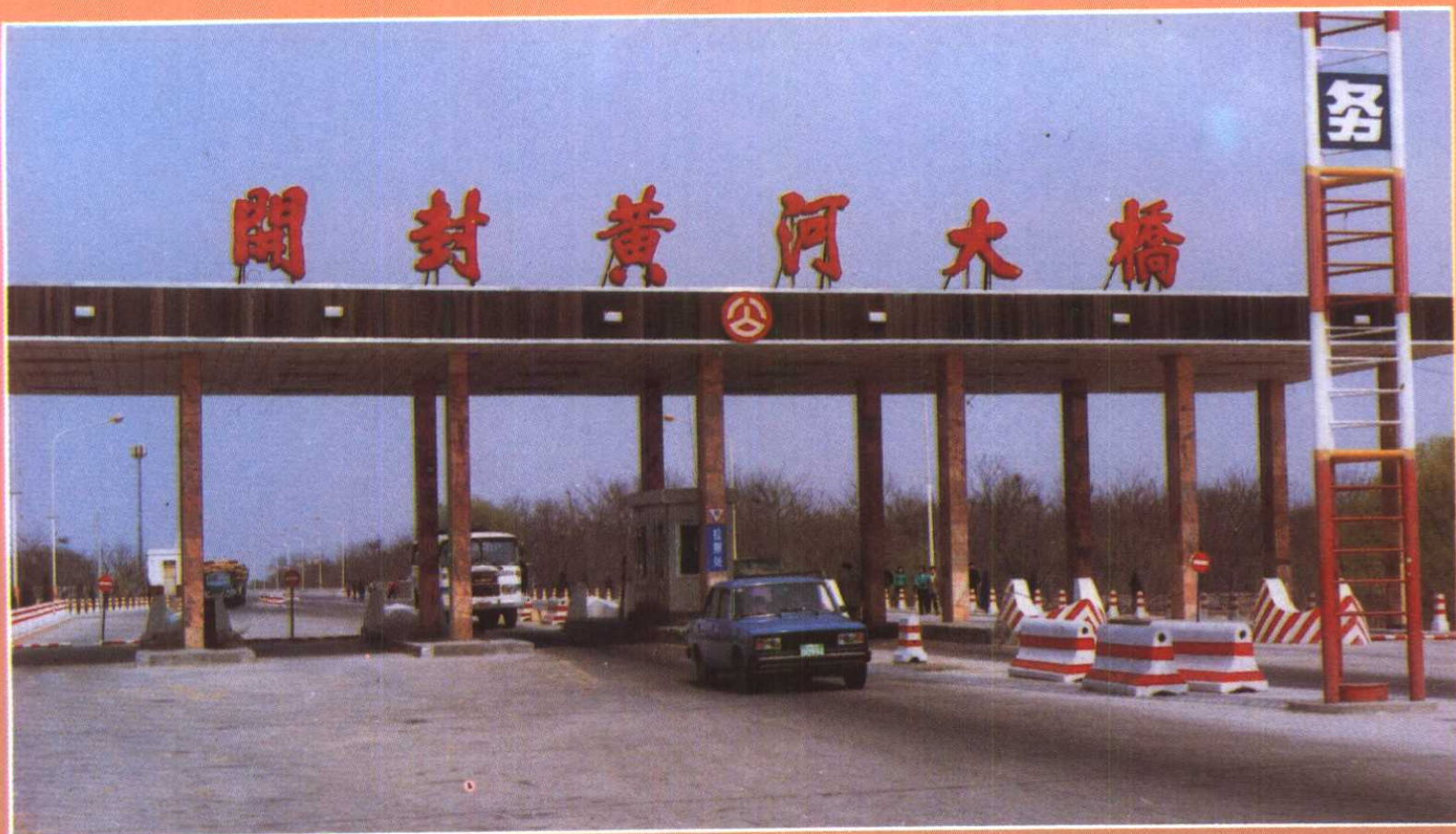
开封黄河公路大桥
