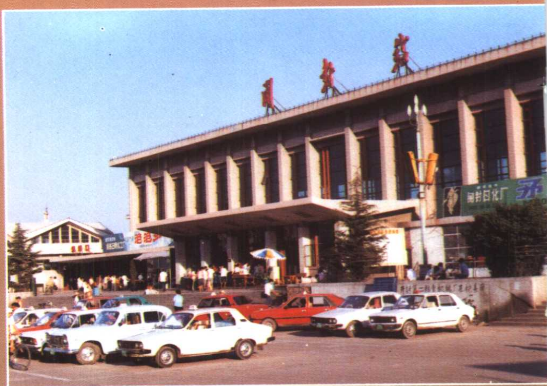
开封火车站客运候车楼
