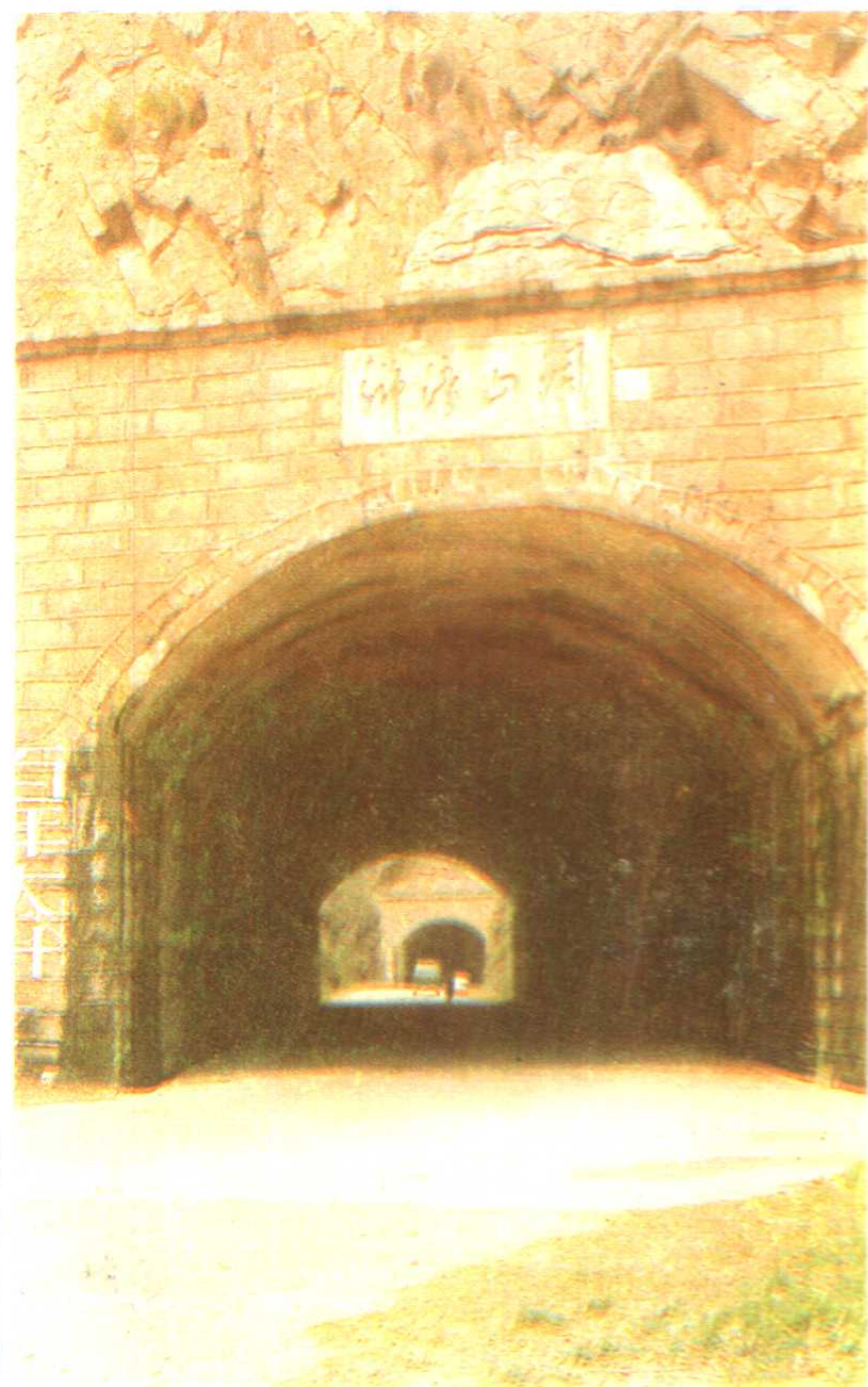
寨檀公路浒湾山洞
