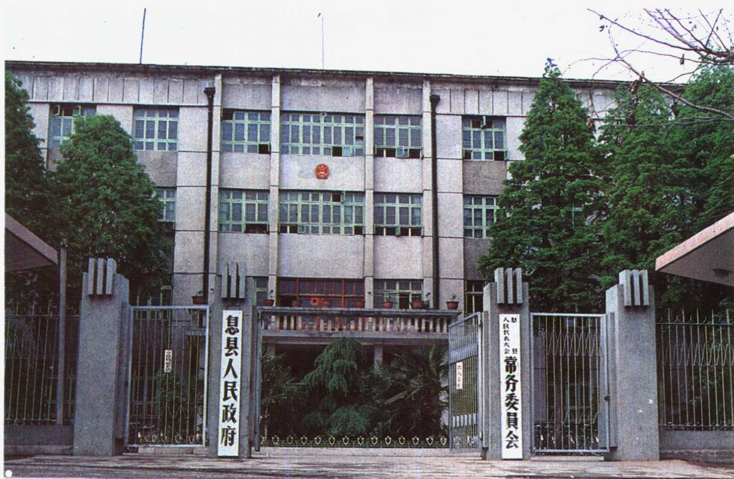
县政府、县人大办公大楼
