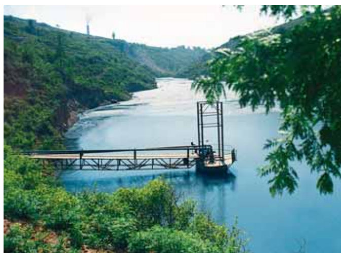
天成电化公司修建的污水处理站
