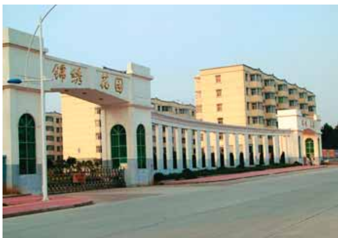
锦绣花园住宅小区
