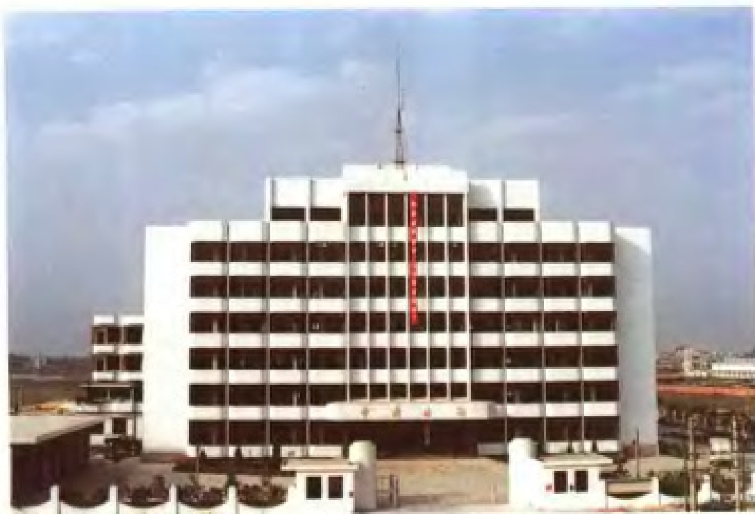
位于鹤山市的鹤山海关办公楼
