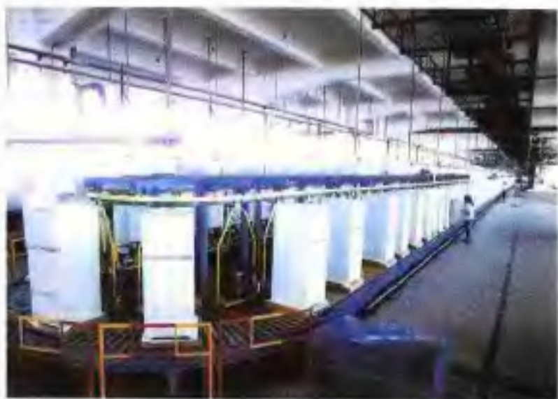
万宝电器集团公司电冰箱生产线
