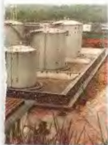
工产品仓库罐区 (1990年)
