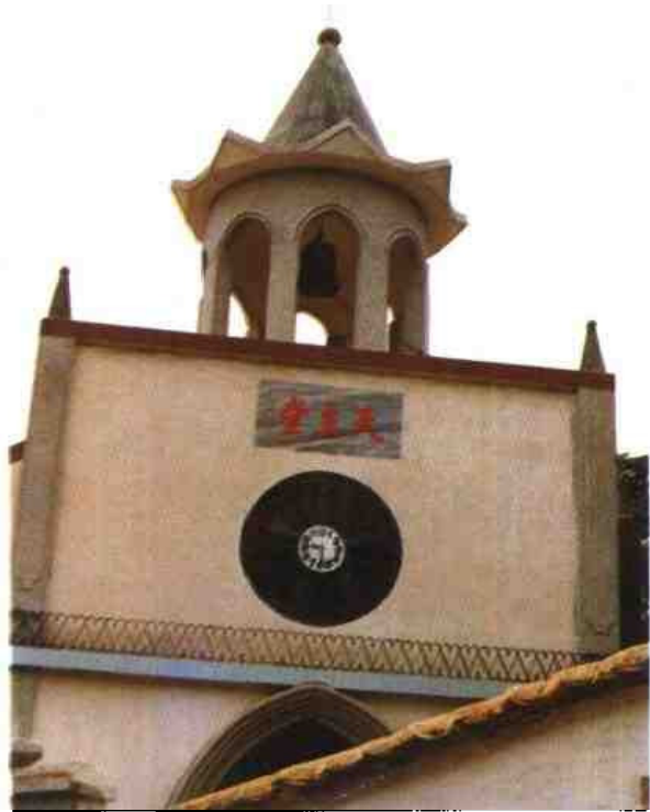
修复于1988年的梧州市天主堂钟楼。
