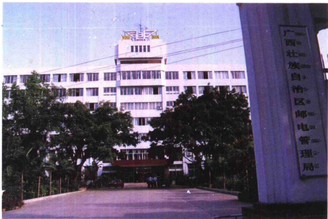
1989年建成的自治区 邮电管理局综合办公 大楼。
