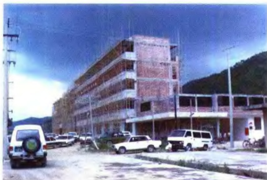
1985年开始建设的荔浦县民政经济开发区。
