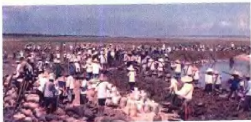
合浦县广大灾民积极投入抢收斗争，修建被冲垮冲毁的桥梁。
