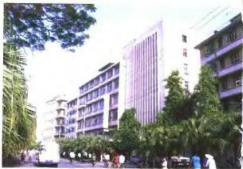
自治区民政福利企业公司大楼。
