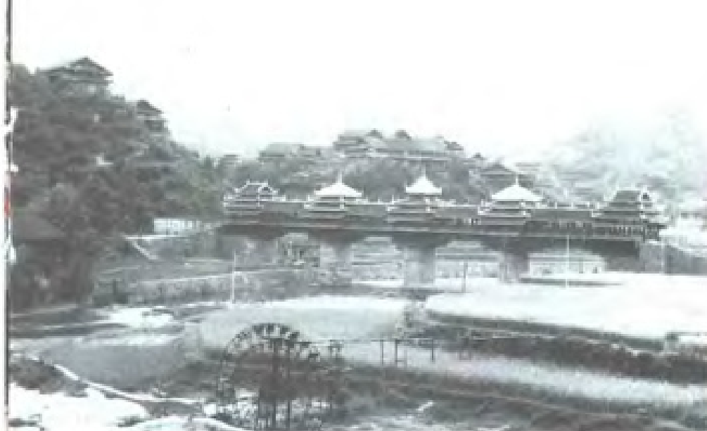
三江侗寨程阳风雨桥。（洪永洪摄）
