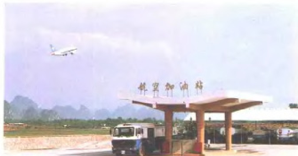
桂林机场航空加油站。
