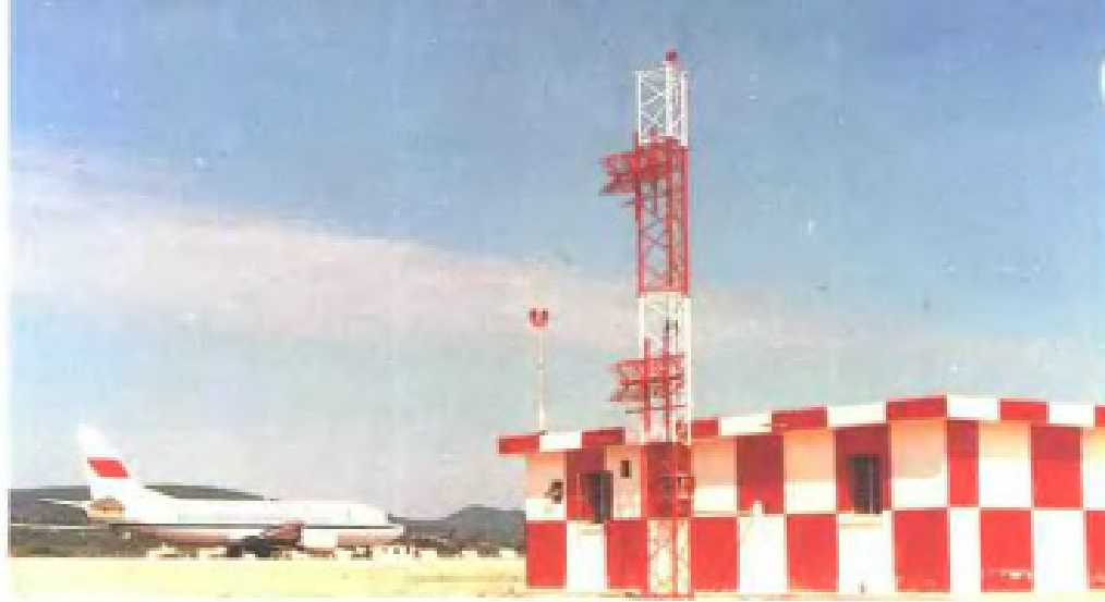
桂林机场盲降设施一角。
