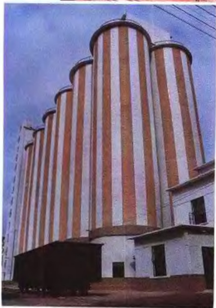
南宁市白苍岭大米厂粮食仓库。
