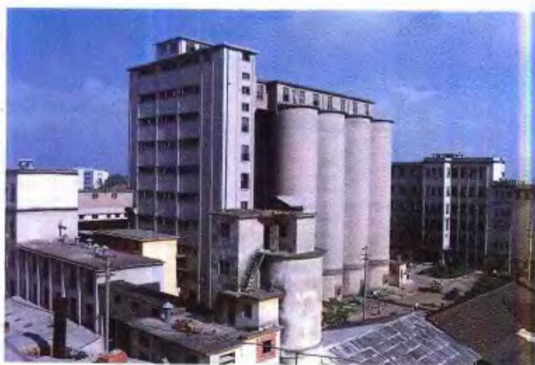
南宁面粉厂全貌。
