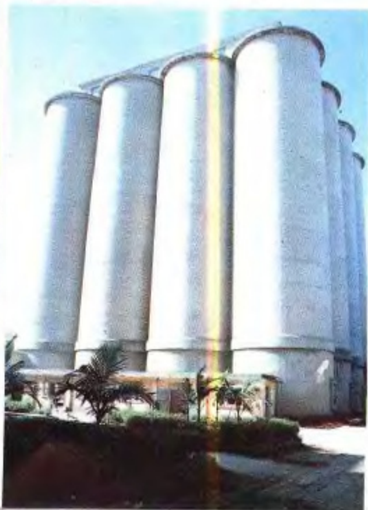
南宁面粉厂立筒库(共 12 个筒)。
