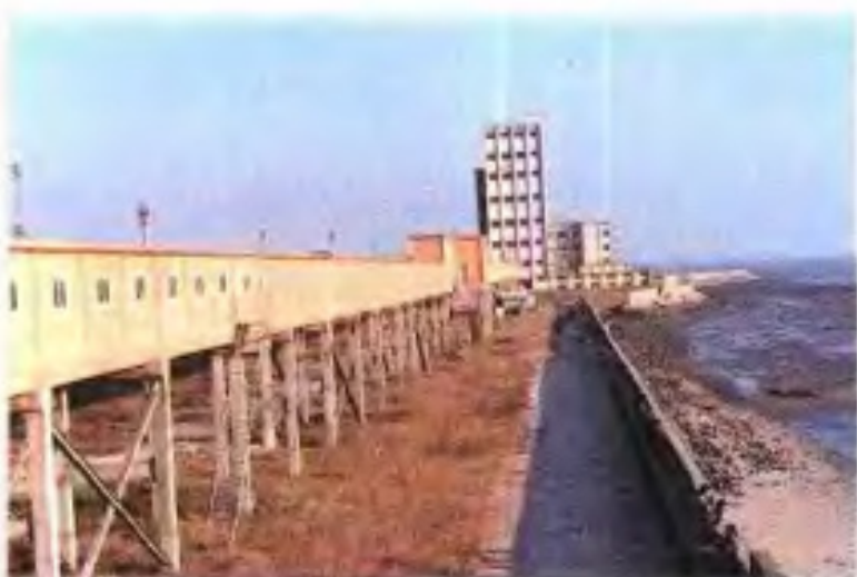
防城港区粮食输送线外景。
