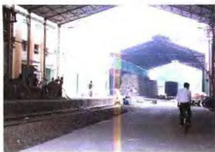
南宁市白苍岭大米厂铁路专用线货棚。
