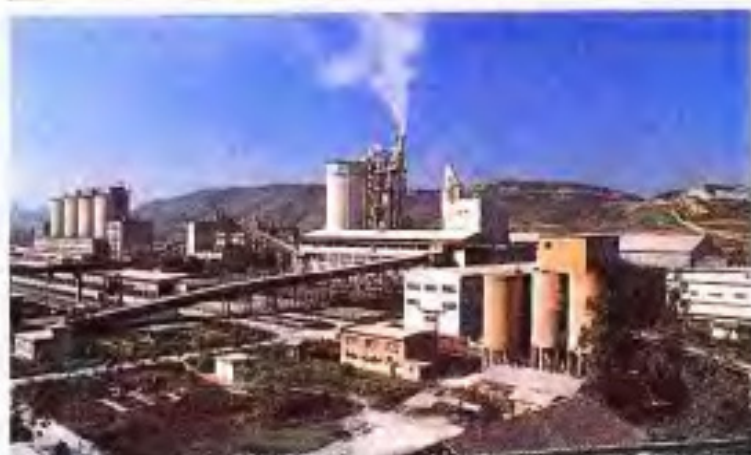
▶柳州水泥厂全景。该厂1959年引进捷克诺洛设备,1964年投产,年产60万吨,经过改造达到65万吨。1982年引进丹麦干法窑外分解生产线,1986年建成。新增生产能力年106万吨,总能力年171万吨。
